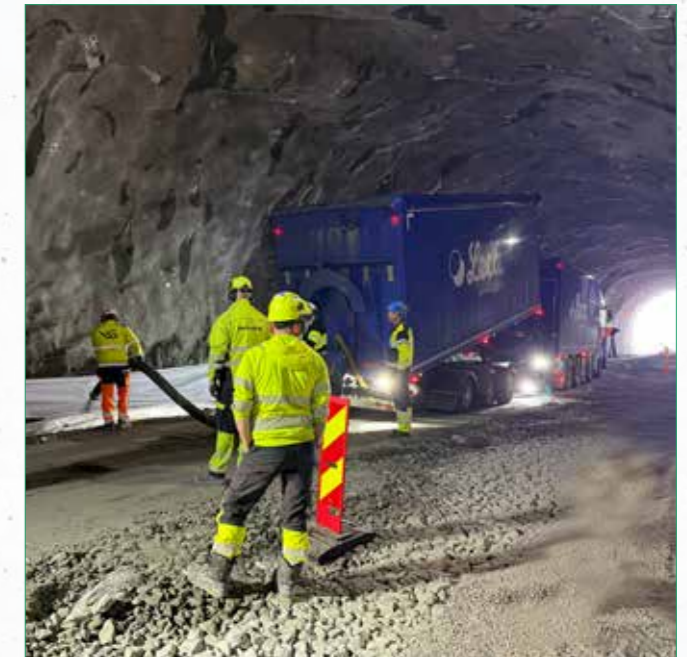
Håloglandsveien - innblåsing av Leca i rørgate for SKANSKA
