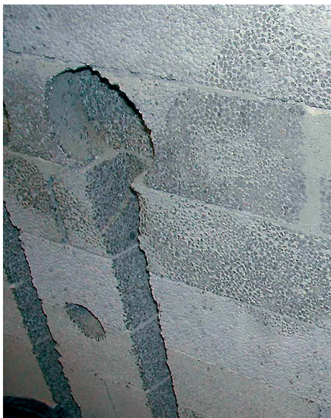
Figur 4.43 Spor til rør i slisset Leca vegg
