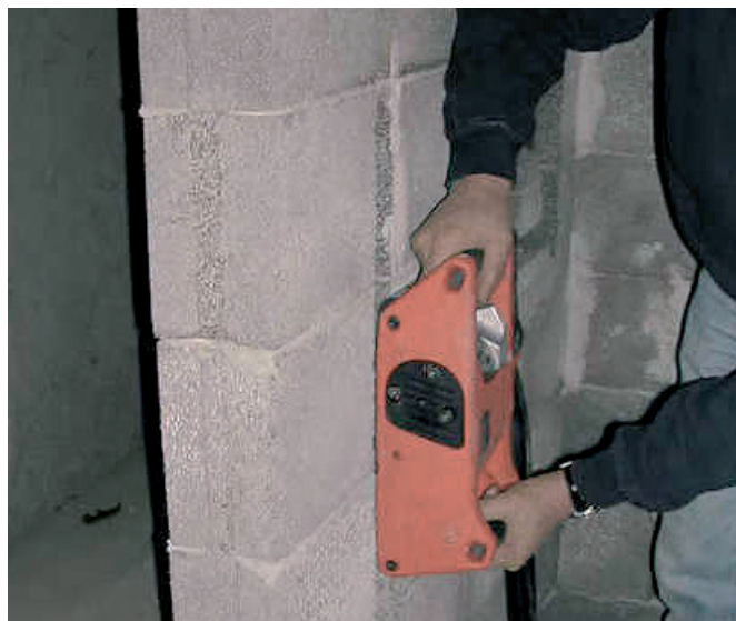
Figur 4.41 Slissing av spor for rør
