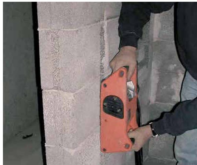
Figur 4.41 Slissing av spor for rør
