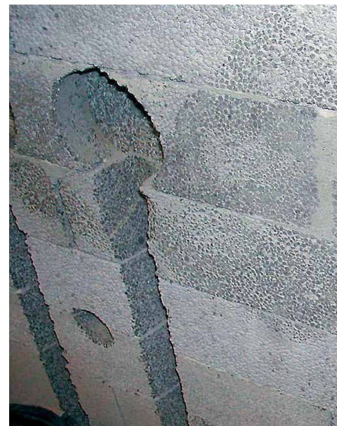
Figur 4.43 Spor til rør i slisset Leca vegg
