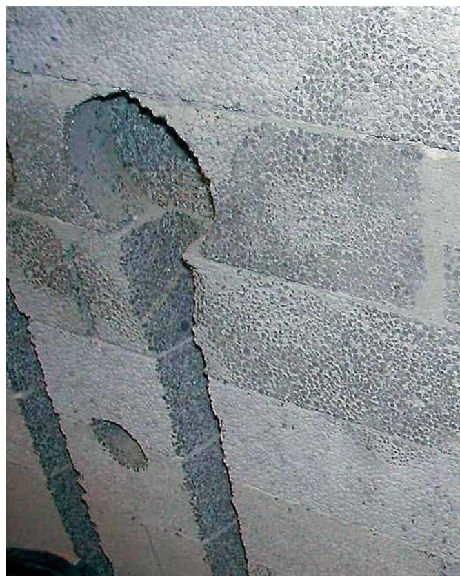
Figur 4.43 Spor til rør i slisset Leca vegg
