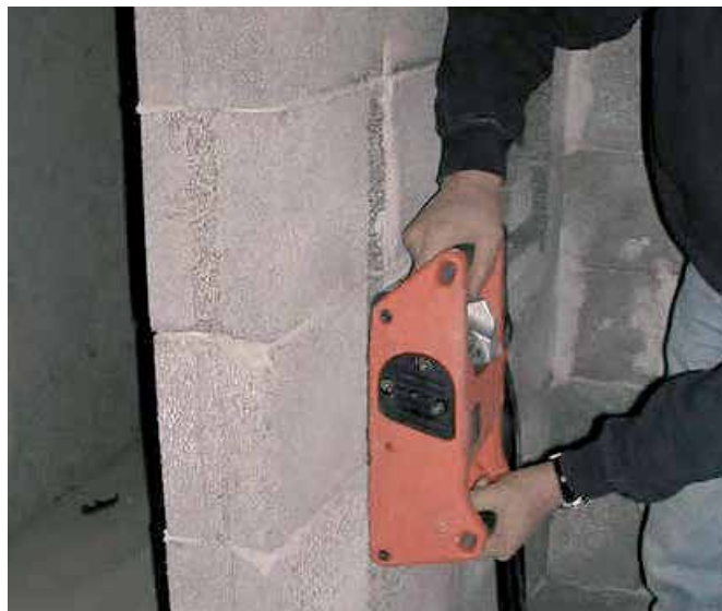
Figur 4.41 Slissing av spor for rør
