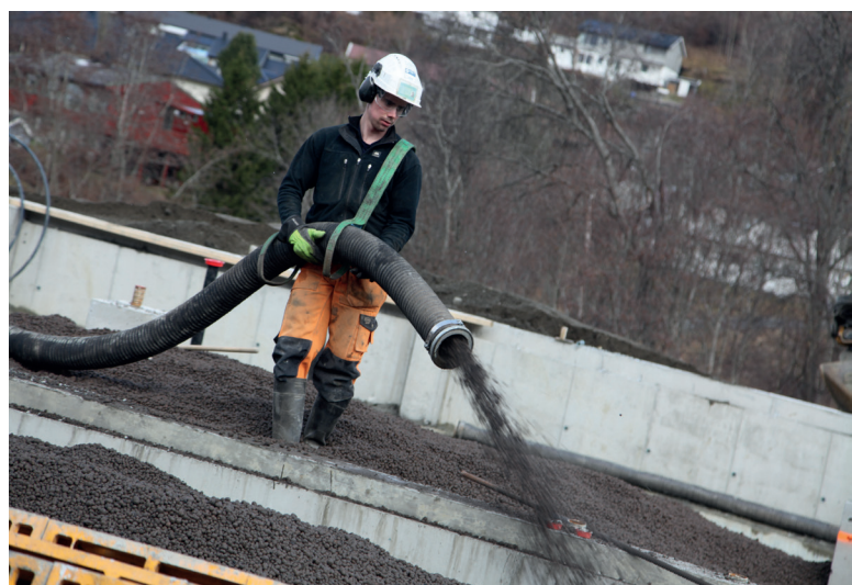
Leca blåses direkte på plass, en rask og effektiv løsning.
