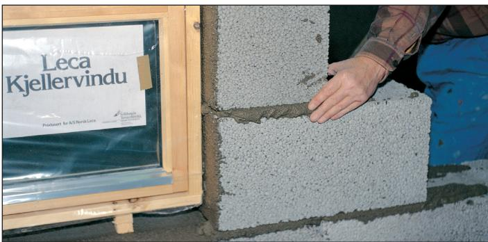
Du må sette av åpninger for vinduene og for ventilene. Ventilene sitter lavt i 2. skift for å gi en god gjennomlufting. Både vinduer og ventilører kan settes inn samtidig som blokkene mures.
