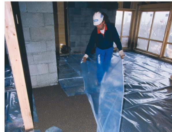
Plastfolie (0,2 mm tykkelse) - evt. radonmembran - legges ut som fuktsperre i gulvet.
