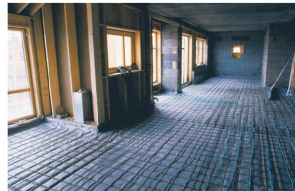
Armeringsnett minimum K 131 legges direkte på fiberduken for å stabilisere løs Leca-laget. Det er viktig å påse at armeringen ikke perforerer radonmembranen. Ved eventuelt bruk av varmekabler/vannbåren varme, festes disse til armeringsnettet med plaststrips eller lignende.
