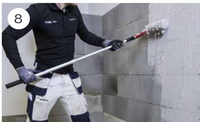
8 Leca Lettvegg har en fin overflatestruktur og kan sparkles i stedet for å pusses. Til det brukes en av de to spesialsparklene weber Sparkel, som kan påføres med stålsparkel, eller weber Sparkel RS, som kan påføres med malerulle eller sprøyte.
