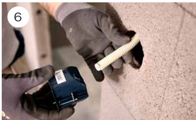
6 Vegguttak for rør kan f.eks. tas med egnet hullbor og koblingsboks festes i veggen.
