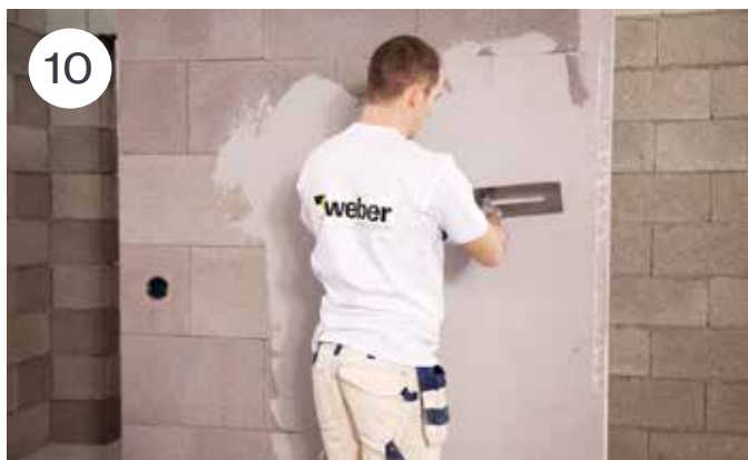
10 Deretter påføres første sjikt av sparkelen med egnet redskap. Til forsterkning rundt åpninger hvor dette er nødvendig, brukes et fibernettt som bakes inn i sparkelen.
