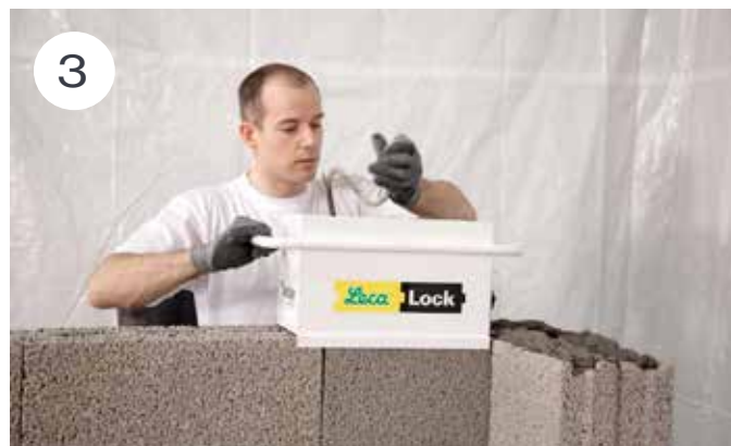
3 Weber Murmørtel M5 er en spesialmørtel for utlegging med mørtelkasse. Bland mørtelen i ht anvisningen på sekken, hell den blandede massen i mørtelkassen, og dra kassen langsomt over blokkene. Da får du riktig mengde mørtel på riktig plass på aller enkleste og raskeste måte.
