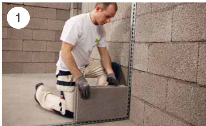
Første blokk settes tørt i hjørnet, i sporet fra lettveggsskinnene.
