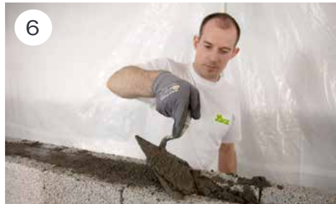
6 Deretter fylles U-blokksporet med Weber B20 Tørrbetong. Toppen avrettes og overflødig betong trekkes av.
