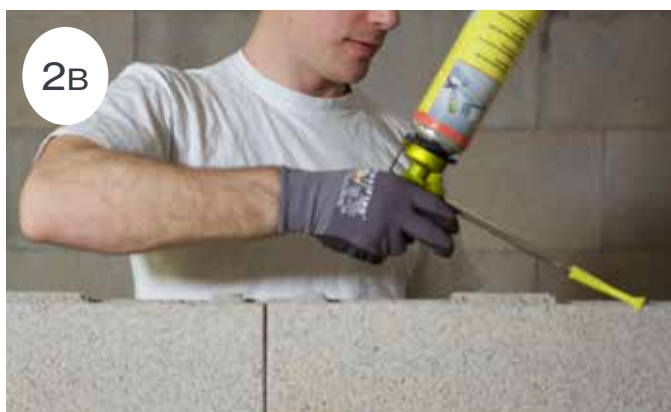
En alternativ limemetode som er både enklere og raskere, er å bruke weber Stone Fix – lim på boks. Limet sprayeres på plass med Twin Tip dyse. Limet er meget sterkt, herder fort og veier nesten ingenting.
