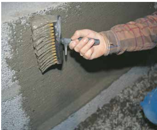
Weber Grå Slemming påføres i to sjikt under bakken og bak grunnmursplate. Forbruk ca 6 kg pr m 2 .
