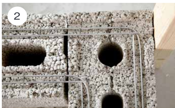
2 Fugearmering legges i begge armeringssporene. I hjørneblokkene plasseres de slik. Armering legges i første skift, og deretter annet hvert skift.
