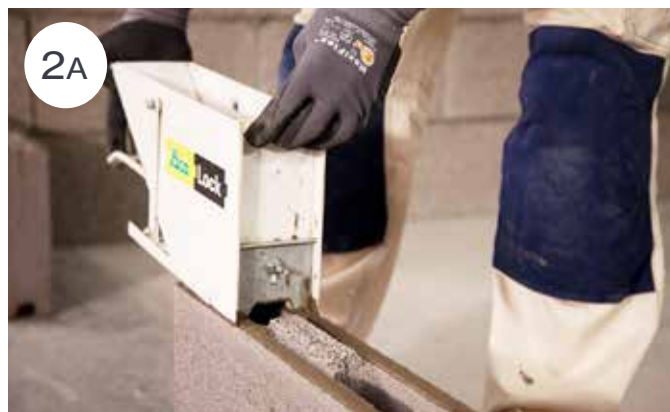
Leca Lettvegg skal ikke mures, den skal limes. Weber Blokklim OL15 blandes i ht anvisning på sekken, og helles i Leca Limkasse. Sett Limkassen oppå blokkskiftet og dra den støtt over blokkene.
