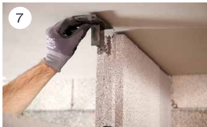
7 I tak festes lettveggen med Leca Lettvegg Toppforankring som gir nødvendig sideavstivning for veggen.
