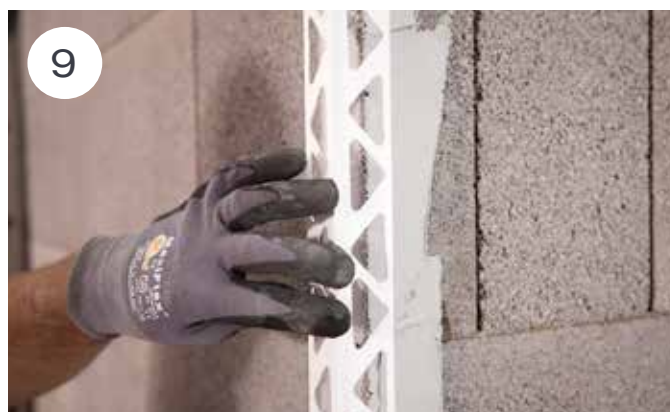
9 På utvendige hjørner bruker du Hjørneprofil 4 mm, som bakes inn i sparkelen.
