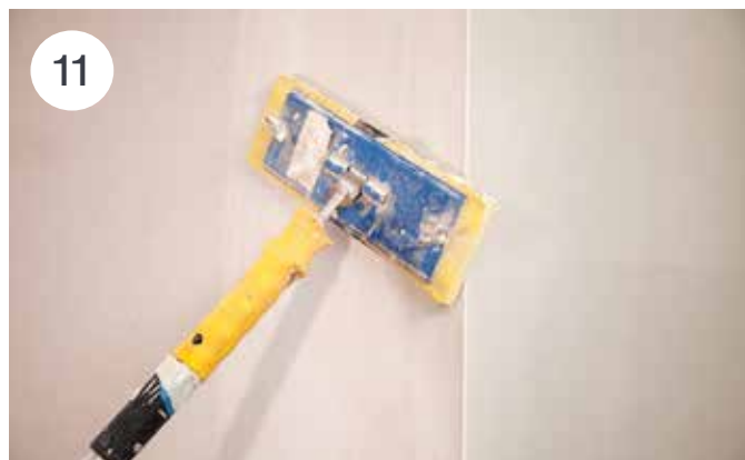
11 Når sparkelen er tørr slipes den lett med fint sandpapir, og et nytt sjikt med sparkel legges på. Neste dag kan dette pusses, og veggen er klar for maling. En mye enklere metode enn å pusse en Leca-vegg.
