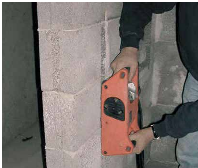
Figur 4.41 Slissing av spor for rør
