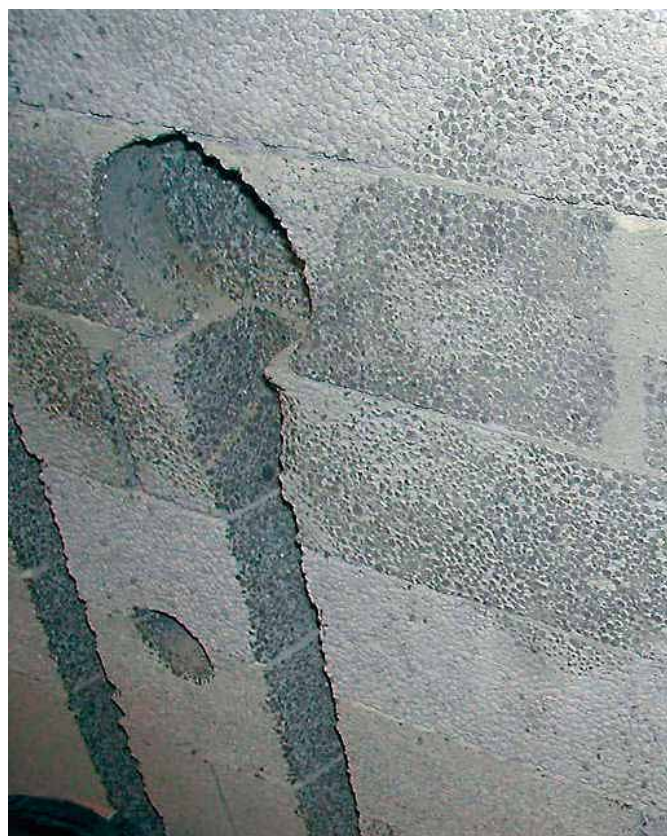
Figur 4.43 Spor til rør i slisset Leca vegg
