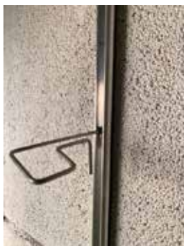
Figur 9.3b Forankring Leca Fasadeblokk
