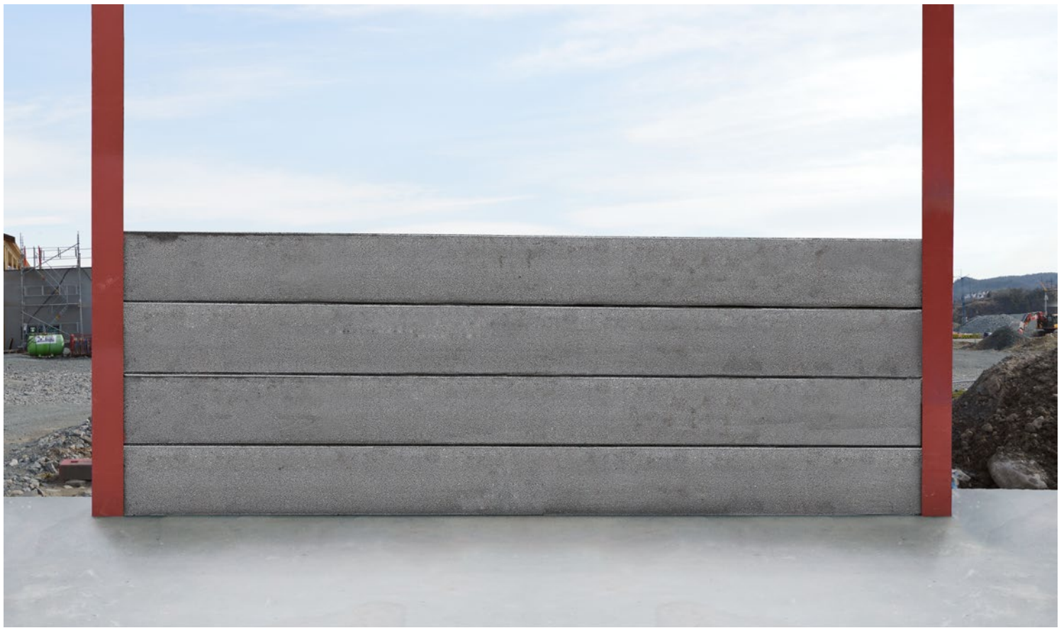
Leca Veggelementer montert mellom stålsøyler av H-profil. Elementene stables oppå hverandre i steget på søylene.
