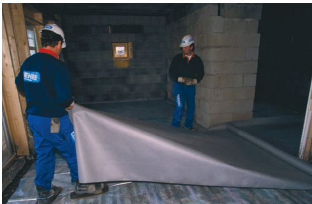
Weber.floor 4940 Fiberduk legges over plastfolien (evt. radonmembranen), brettes og festes opp langs vegg (oppbrett ca. 100 mm). Dette for å hindre avrettingsmassen i å trenge ned i underliggende materiale.
