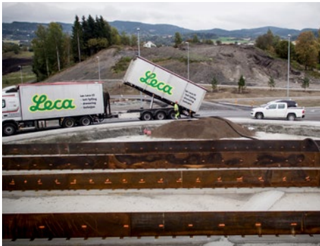
VEKTREDUKSJON: Leca Lettklinker ga vektreduksjoner på Riksvei 4 på Gran.
