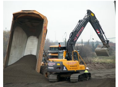
STABILISERING: Motorvei og jernbane skulle bygges over et myrområde i Grimsby i England. Løsningen ble Leca Lettklinker.
