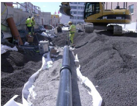
STABILISERING: Spårvagnshallarna i Gøteborg. Her løste Leca Lettklinker problemer med setninger og stabilitet.
