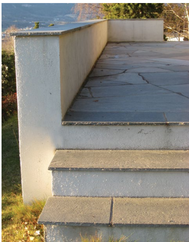
Mur i kombinasjon med terrasseløsning.
