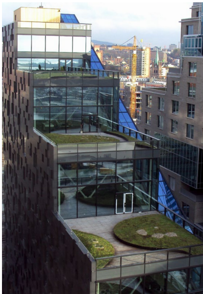
GRØNNE TAK: Leca Lettklinker i grønne tak, her i Bjørvika i Oslo, gir fordøynings-effekt, isolasjon og drenering.
