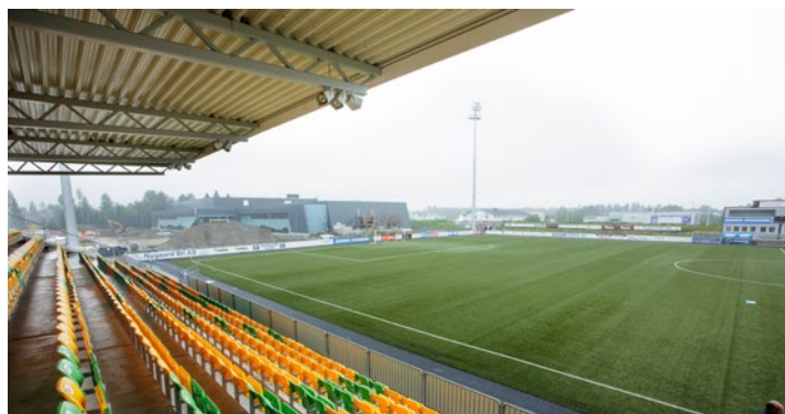
DRENERING: I Norge er hundrevis av kunstgressbaner isolert og drenert med Leca Lettklinker.
