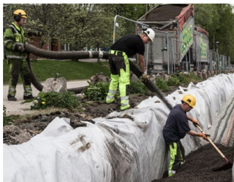
FROSTSIKRING: Leca lettlinker ga en effektiv og økonomisk løsning ved bygging av grunne grøfter på Sognsvann i Oslo.
