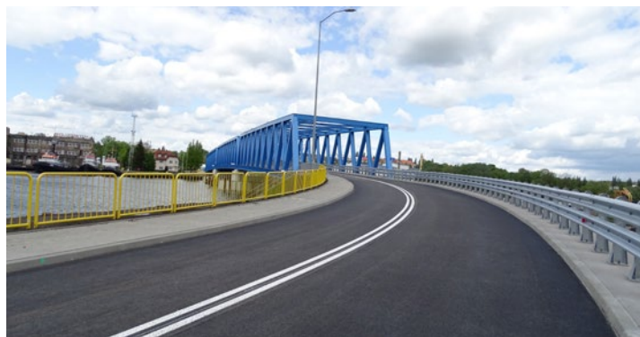
STABILISERING: Denne broen i Szczecin i Polen hadde dårlige grunnforhold ved brohodene. Dette ble løst med Leca Lettklinker.
