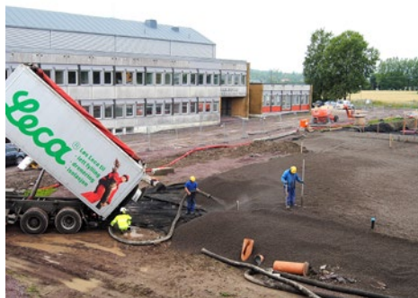
DRENERING: Mengder av store og små bygg har Leca Lettklinker i grunnen for drenering og isolasjon.
