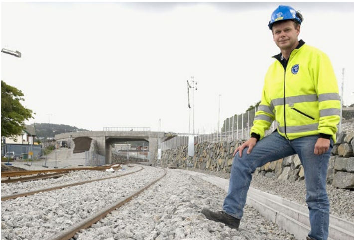
JORDTRYKK: På togtraséen mellom Sandnes og Stavanger har Leca Lettklinker løst problemet med jordtrykk og setninger.
