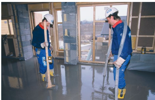
Weber.floor 140 Nova (evt 4150 FibreFlow Rapid) legges ut i en tykkelse på 30-40 mm. På større gulvjobber anbefales bruk av Sertifiserte Weber Gulventreprenører.
