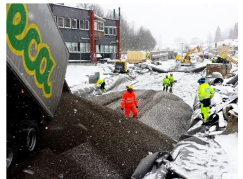
FROSTSIKRING: Kolsåsbanen utenfor Oslo er frostsikret med Leca Lettklinker.
