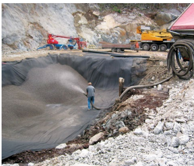
FØR: Leca Lettklinker blåses inn som erstatning for dårlig masse under bensinstasjon.
