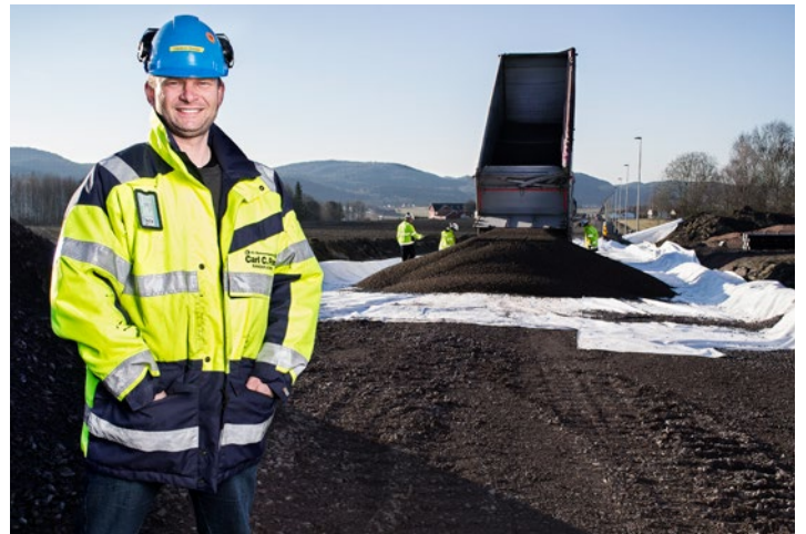
FROSTSIKRING: Leca Lettklinker løste frostsikringsproblemer på Fylkesvei 34 nær Drammen.
