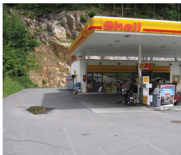
ETTER: Bensinstasjon bygd opp på masse av Leca Lettklinker.
