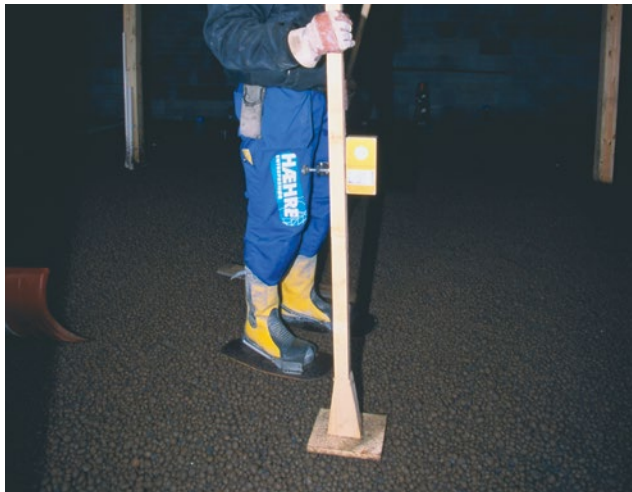
Innblåsing og avretting som betongutførelse.
