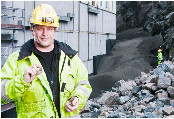
JORDTRYKK: På denne boligblokken i Oslo ga Leca Lettklinker redusert trykk mot muren, og sparte store betongkostnader.
