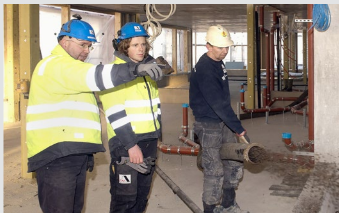
"66 meter rør er ført frem, og blåsingen av Leca Iso 10-20 er i gang." F.v. prosjektleder Per Chr. Røde Evensen og anleggsleder Axel Bryde.
