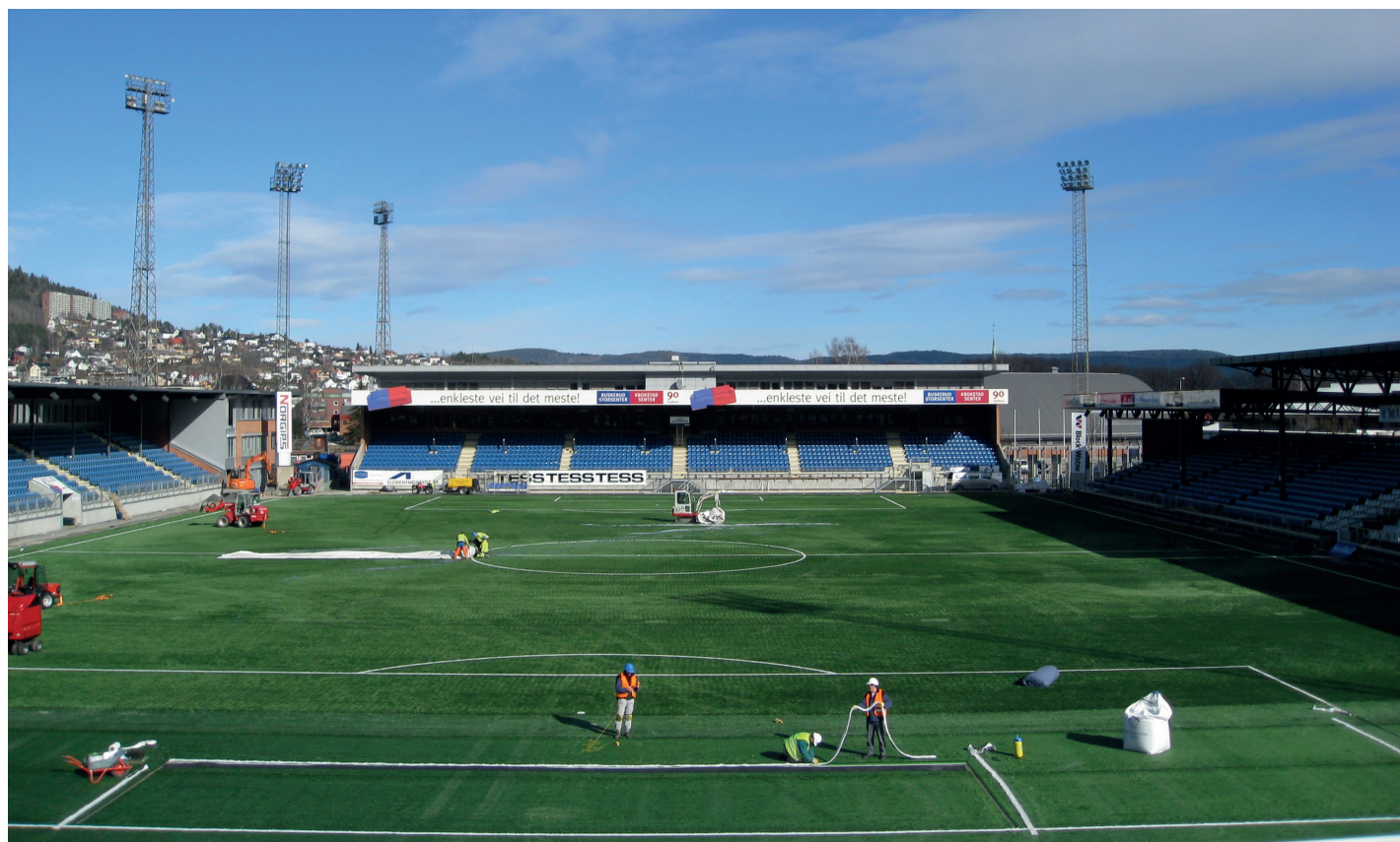
Marienlyst Stadion i Drammen ble ferdig utlagt og avrettet på tre dager.
