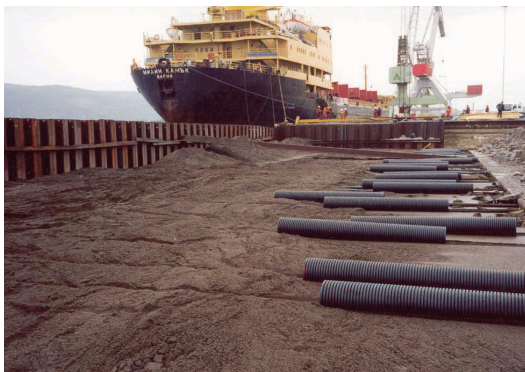
Bygging av massivkai med Leca® Lettklinker.
