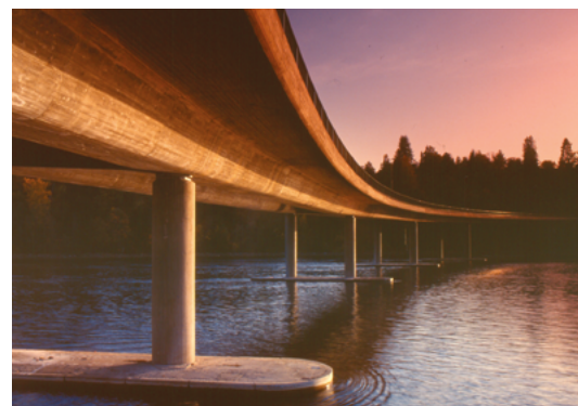
Ny Sundbru, Eidsvoll. Høyfast Leca® Lettbetong
