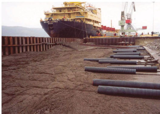
Bygging av massivkai med Leca® Lettklinker.
