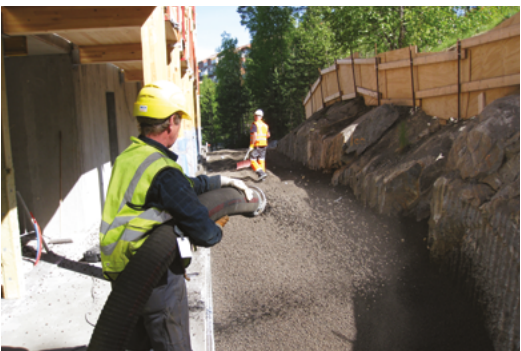
Referanseprosjekt tilbakefylling på Mortensrud, Oslo.
