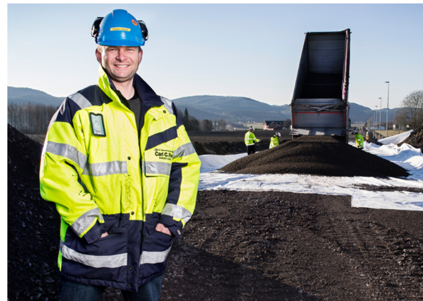
Ved rehabilitering av Unelrudlina på Fv34 sør for Drammen ble Leca® Lettklinker benyttet til frostsikring. Den gamle veien var helt ødelagt av telehiv.
