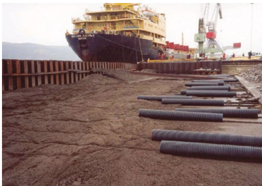
Bygging av massivkai med Leca Lettklinker.
