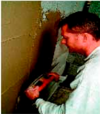
1) 1 sjikt Fiberpuss trekkes på i 4-6 mm.
