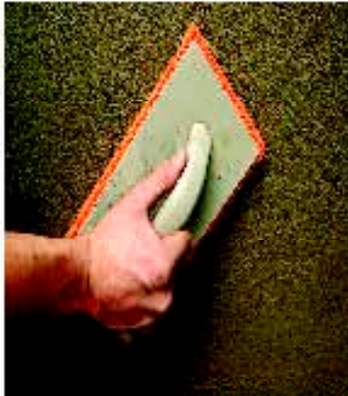
5) Fiberpuss filses evt. kastes eller brettskures.
