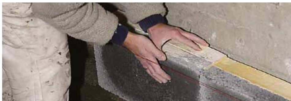
Innvendig bruk av Leca Fasadeblokk er en enkel form for etterisolering.
