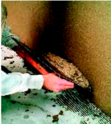
4) 2 sjikt Fiberpuss trekkes på i 3-4 mm 1-3 dager etter første sjikt.
