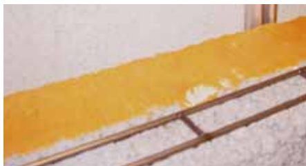
Leca Fugearmering utlagt
