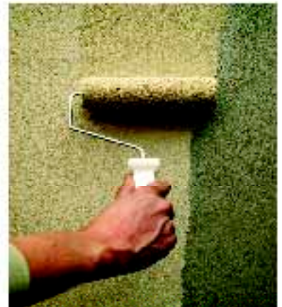
6) Sluttbehandling påføres etter ca 14 dager herding.
