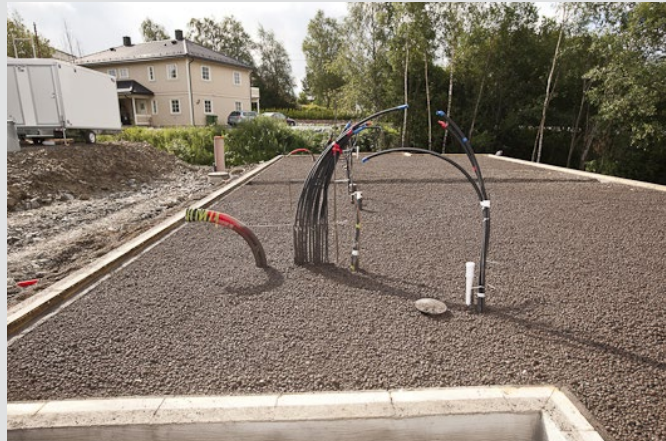
13. Ringmuren er nå klar for oppbygging av gulv.
