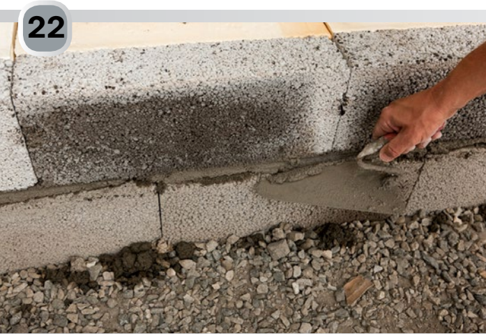
Eventuelt overflødig mørtel trekkes av med murskje.
