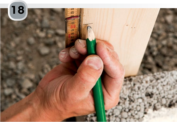
Når du har markert toppen, lager du merker for hver skifthyde nedover. For Isoblokk 35 cm er ett skift på 20 cm (19 cm blokkhøyde og 1 cm mørtelfuge).
