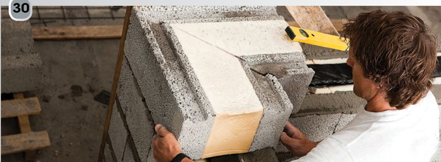
Det øverste skiftet skal alltid armeres, derfor leveres en egen Toppblokk som inneholder to spor for armering.
