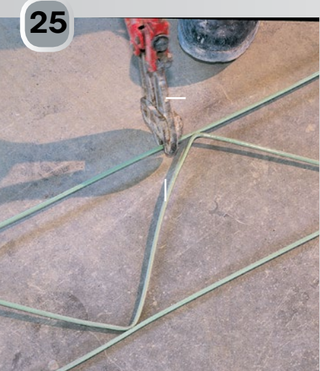
Slik kappes og bøyes Sikksakk-armeringen rundt hjørner
