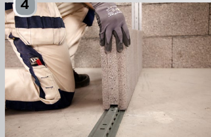
Deretter er det bare å fortsette med å sette blokk inntil blokk. Takket være not og fjær på fire sider, "låses" blokkene i hverandre.
