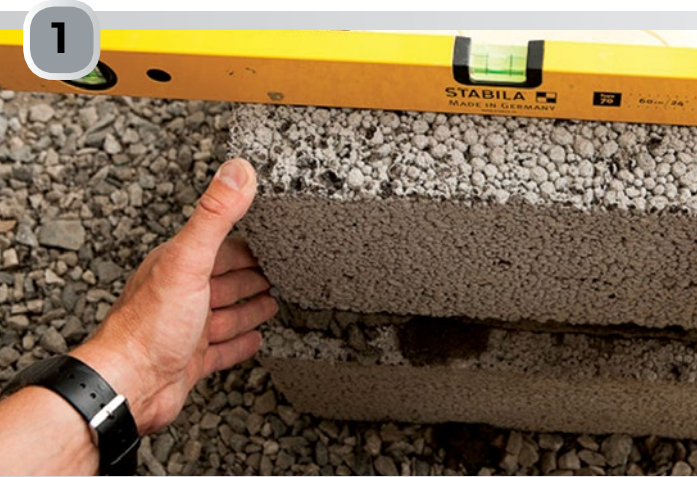
Grunnen rettes av mest mulig plant. I hjørnene plasseres Såleblokker riktig etter kommunens merker, i en pute av jordfuktig weber B20 Tørrbetong. Hjørneblokkene av Leca Såleblokk settes ca 2 cm utenfor grunnmurens vegglin, og vtres i begge retninger. Kontroller vinklene ved å måle diagonalene (se side 10). Bruk målebånd av stål for denne målingen.
