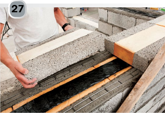
Slik får du riktig høyde på muren: Byggemål pr. skifthyde for Leca Isoblokk 35 cm er 20 cm (inkl. 1 cm mørtel i horisontalfugene). Dersom total murhøyde ikke kan løses ved standard skifthyder 20 cm, leveres det også Tilpasningsblokk til Leca Isoblokk 35 cm. Denne er 9 cm høy (dvs. skifthyde 10 cm inkl. fuge).
