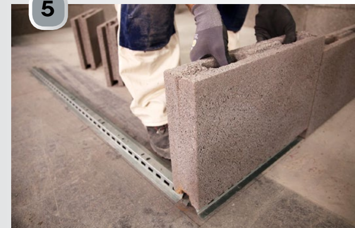
Det finnes egne hjørneblokker som gir skarpe, fine hjørner.
