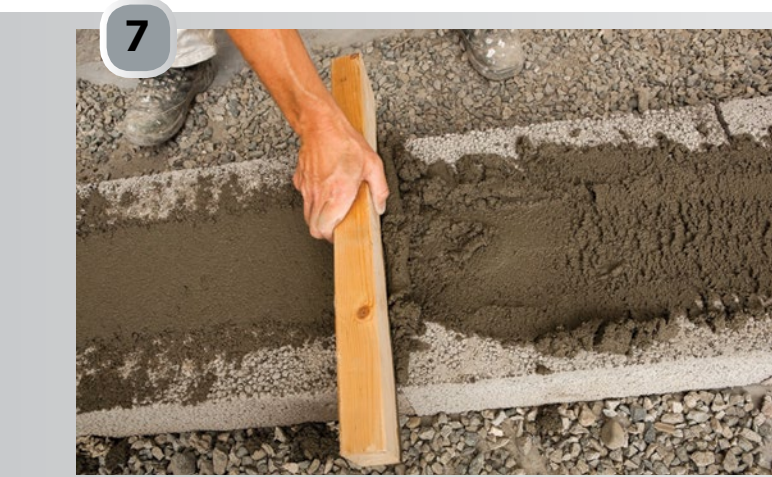
Etterhvert som mørtel ifylles, komprimeres denne noe og avrettes ("sages") med et bord.
