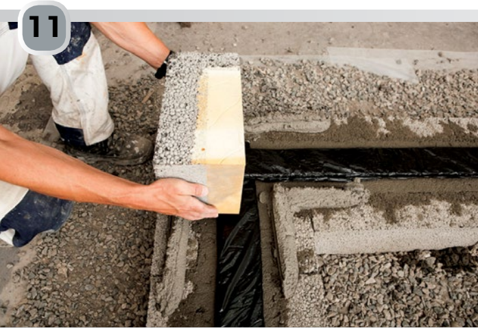
Første Leca Isoblokk 35 cm Hjørneblokk legges riktig på plass
