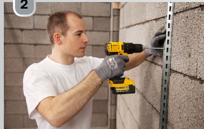
Lettveggsskinne festes også vertikalt i sideveggene for retningsstabilitet og støtte.
