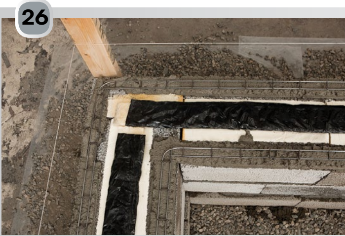
Over bakkeoverflaten bruker du ikke Sikksakk-armering, men Leca fugearmering som vist her. For å få fugearmeringen til å gå rundt hjørnene, kappes en av trådene i armeringen og deretter bøyes armeringen rundt hjørnet.
