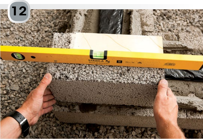
Blokkene vattres nøye. Det skal ikke være papp mellom Såleblokkene og Isoblokkene.
