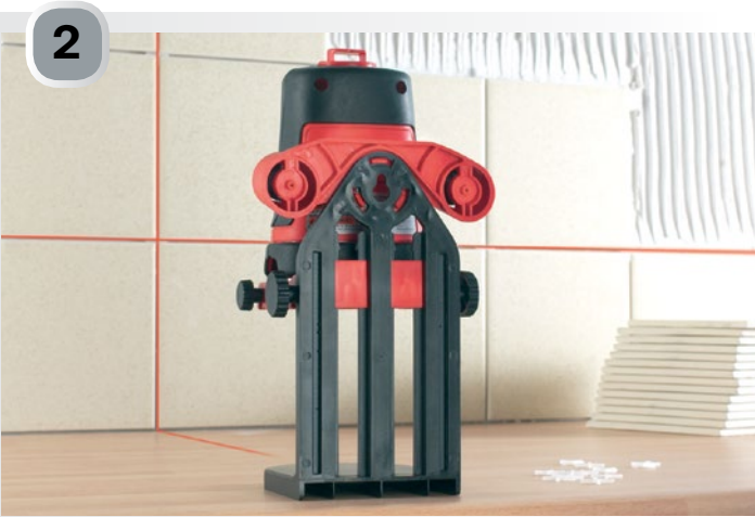
Høyden kontrolleres med laservater, eventuelt nivelleringskikkert. Bruk snor under videre utlegging mellom hjørneblokkene.
