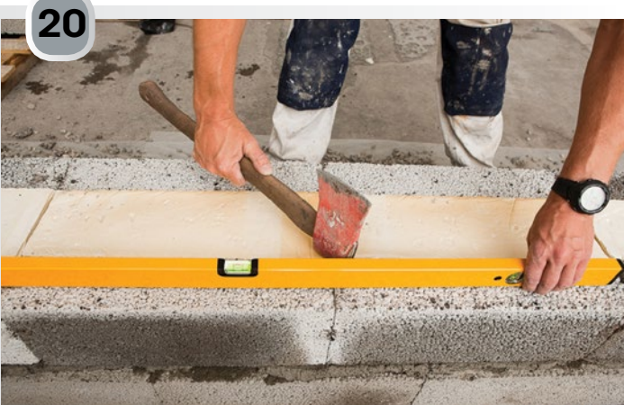
Hver enkelt blokk vattres nøye, blokkene bankes forsiktig på plass med en øks. Avstanden mellom blokker i stussfugene er normalt mindre enn 5 mm. Hvis denne avstanden er mellom 5 og 10 mm, anbefaler vi at avstanden tettes ved bruk av Weber Murmørtel M5 før pussing. Dersom denne avstanden er større enn 10 mm, anbefaler vi at man isolerer stussfugen med byggsaum eller Leca Låfestrimmel før fugegapet tettes ved bruk av weber Murmørtel M5.
