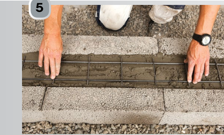
Sporet i Såleblokken armeres med Leca U-blokkarmering. Sørg for å legge armeringen ca. midt i betongstøpen med "tverrtrådene" ned. Ved skjøting i lengderetningen, skal overlapp være minst 30 cm.
