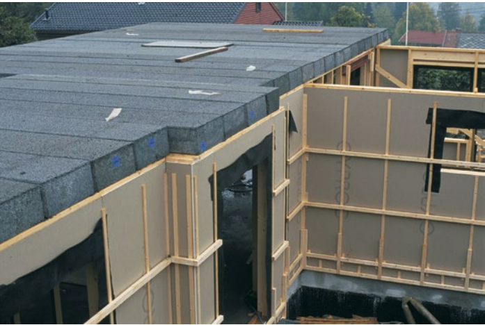
Leca Byggeplank på trevegg
