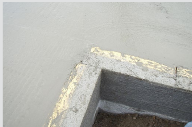
16. Fiks ferdig ringmur med slemmet overflate og støpt gulv. Enkelt og trygt.
