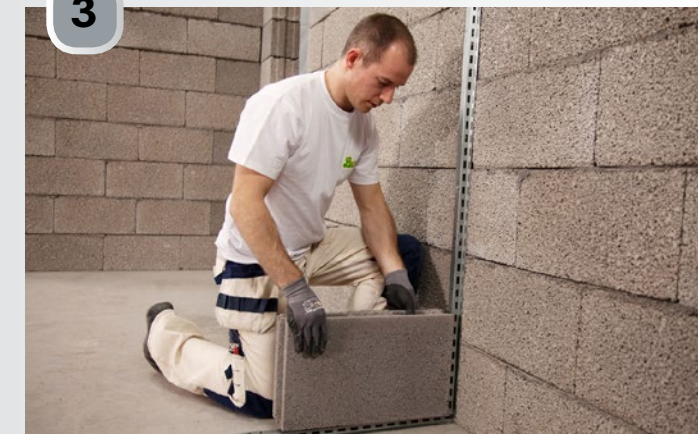
Første blokk settes tørt i hjørnet, i sporet fra lettveggsskinne.
