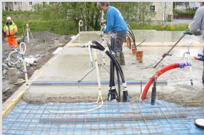
15. Når diffusjonssperre/radonsperre, armeringsstoler og armeringsjern er på plass kan gulvet støpes. Med eller uten gulvvarme.
