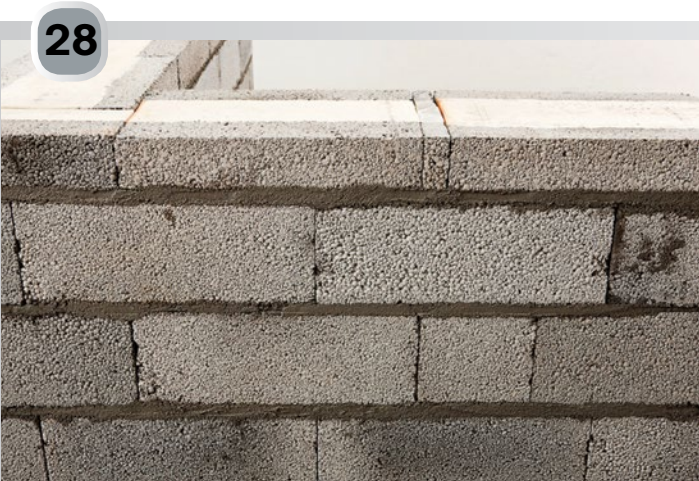
For å oppnå ønsket høyde, kan tilpasningsskift legges enten nederst eller øverst i muren. Hvis man allikevel ikke når riktig murhøyde ved bruk av Tilpasningsblokk, kan blokkene skjæres i riktig høyde med vinkelsliper eller elektrisk lettbefongsag type Alligator. Øverste skift legges med Leca Isoblokk 35 cm Toppblokk
