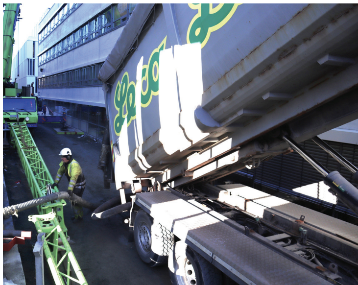
En arbeider hos entreprenøren NCC sørger for at Leca Lettklinker blåses på plass (Foto: Jan Vestre)
