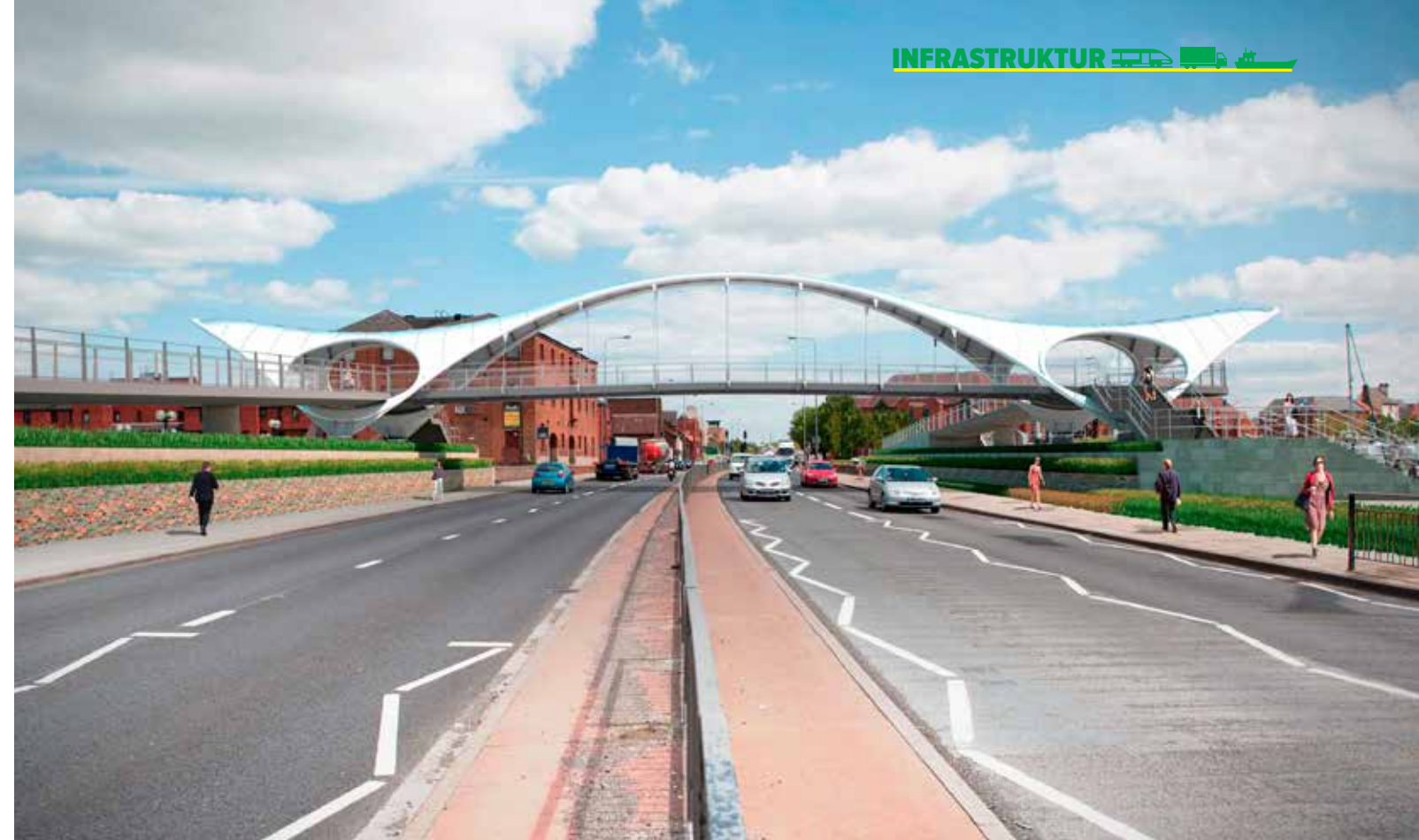
Leca lettklinker ble valgt til fundamenteringen under kaien, slik at man kunne bygge adkomstveier til selve broen.
