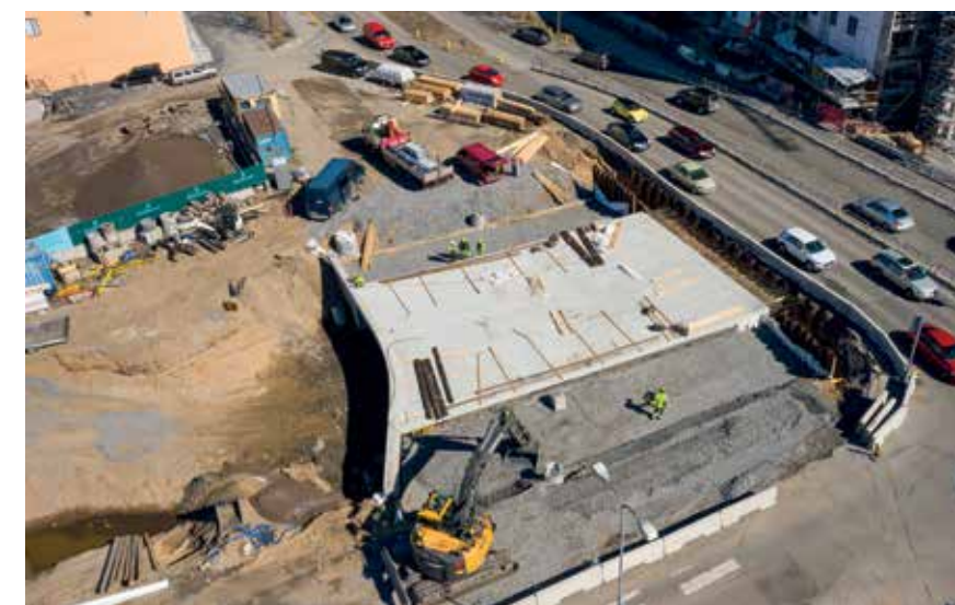
Det ble anlagt en midlertidig lagringsplass for materialet på byggeplassen.
