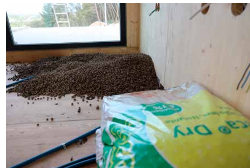
Leca Dry er fyllmasse av ekspandert, tørr leire med et fuktinnhold på under én prosent.
