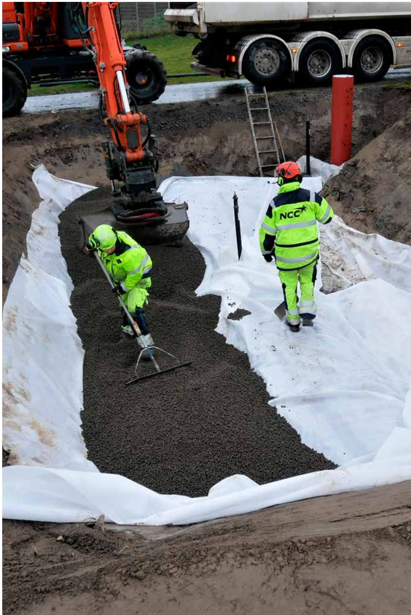
Da det skulle utvikles en ny løsning for rørgater, ble det gjort fullskalatester.
