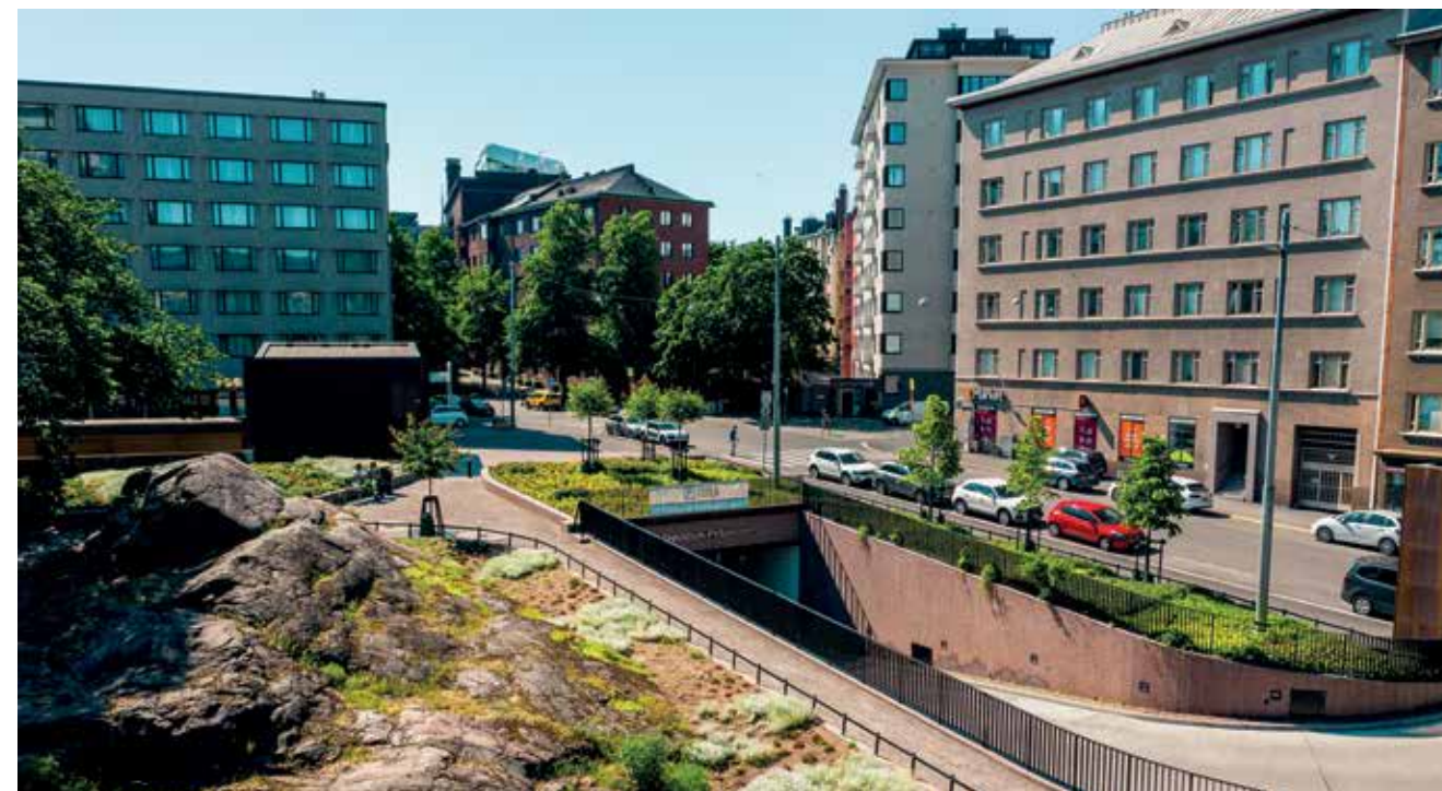
Kivelänkatu-parken er anlagt dels over og dels ved siden av parkeringskjelleren.
