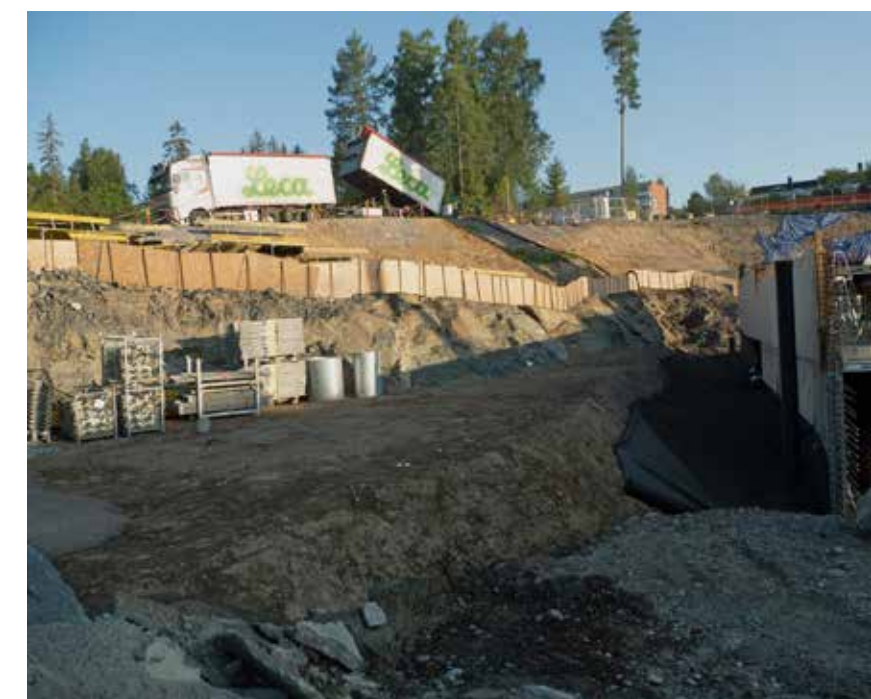
Når bakken er bratt og Leca-kulene skal ned i en byggegrop og rundt hjørner, er det ideelt å kunne blåse dem på plass.
