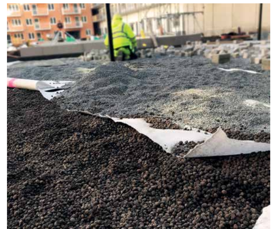
Det at man kunne bruke Leca lettklinker gjorde fyllearbeidet enklere.
