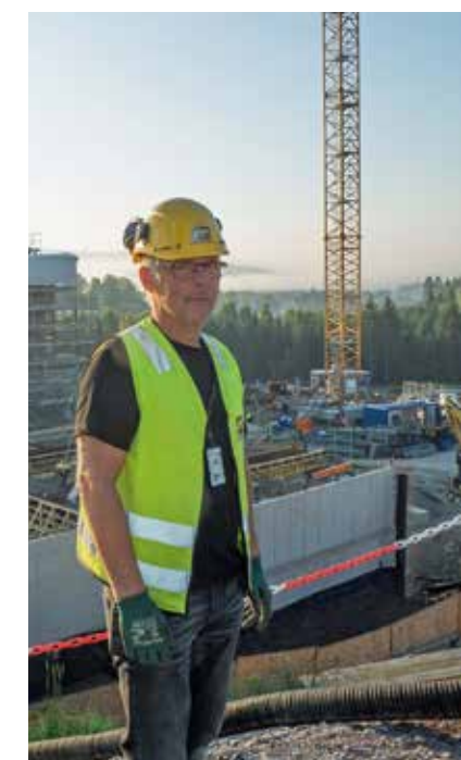
Byggeplassleder Svein Harald Øyhus i morgenso for å ta imot dagens første Leca-levering.
