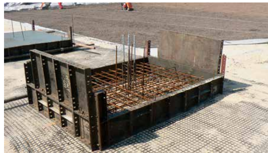
Fundamentering med lettklinker.
