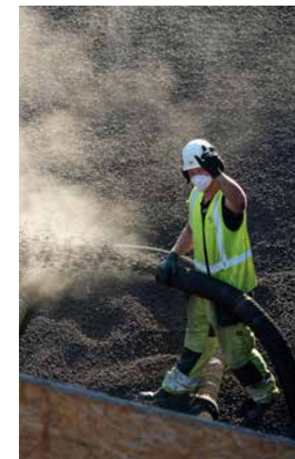
Kulene drenerer og isolerer i tillegg til å sørge for mindre belastning på veggene.
