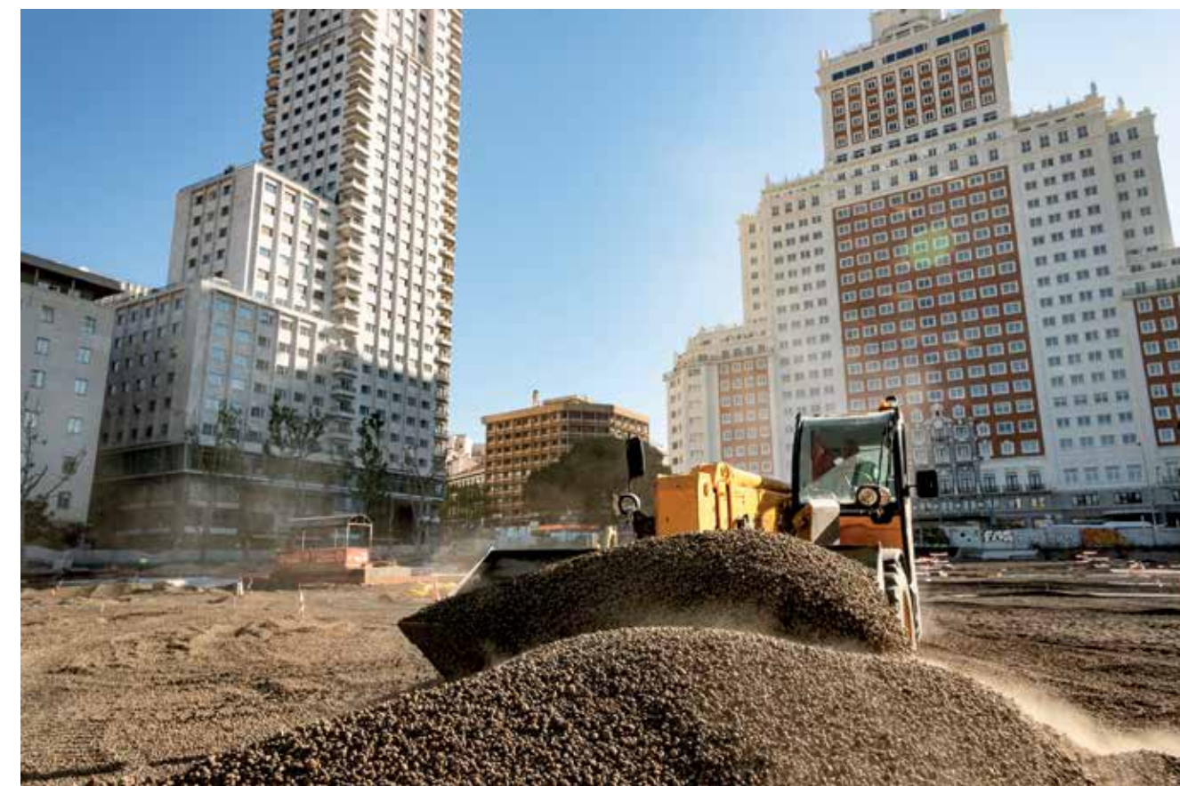
Spredning og komprimering av Leca lettklinker på 10 000 kvadratmeter av plassen.
