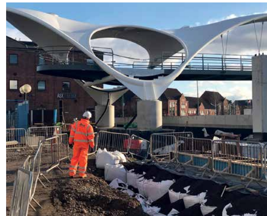
Leca lettklinker ble valgt som fyllmateriale til en fundamentering på seks meter.
