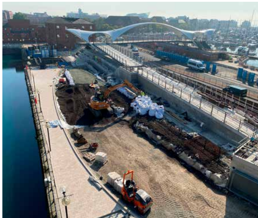
Leca lettklinker ble valgt som fyllmateriale for en seks meter høy konstruksjon.
