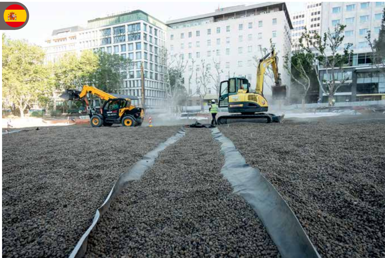
Detalj bilde av utformingen av plassens dreneringssystem.
