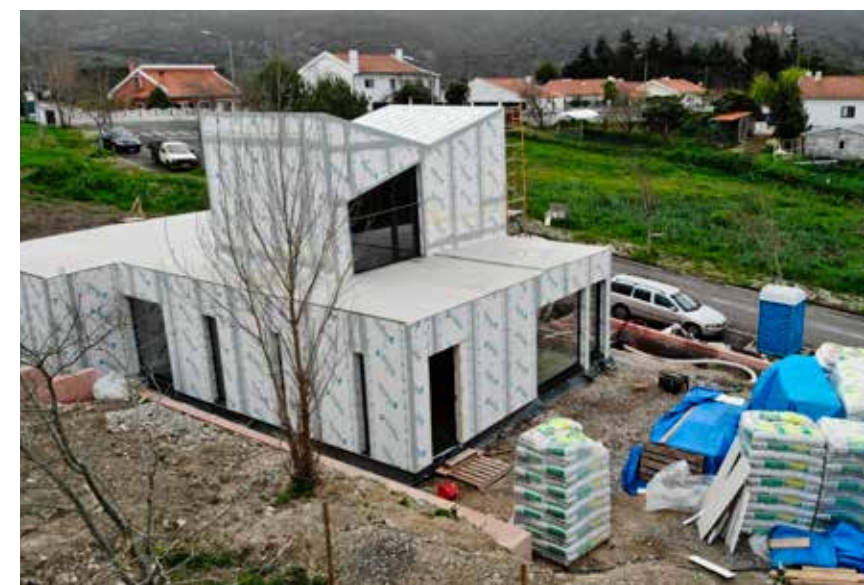
Seks hundre sekker med Leca Dry ble brukt til å isolere gulvene.
