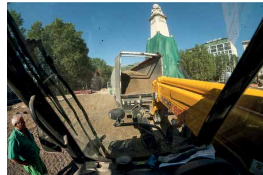
Lossing av Leca lettklinker fra en lastebil med en kapasitet på 75 m 3 .
