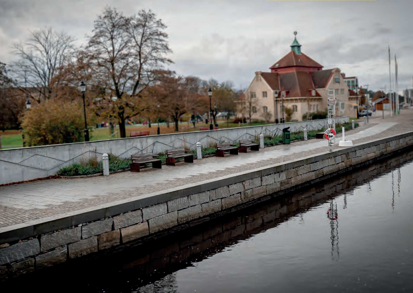
Renoveringen av havneområdet er ferdig, og konstruksjonen forventes å vare veldig lenge.
