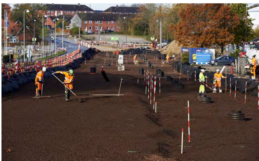
Et lag på 70 cm Leca lettklinker ble brukt i prosjektet.
