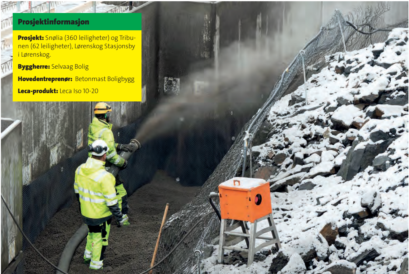
Andrzej Bojarczuk (til venstre) og Eirik Navelsaker sørger for at tilbakefyllingen ikke legger for stort press på bygget.
