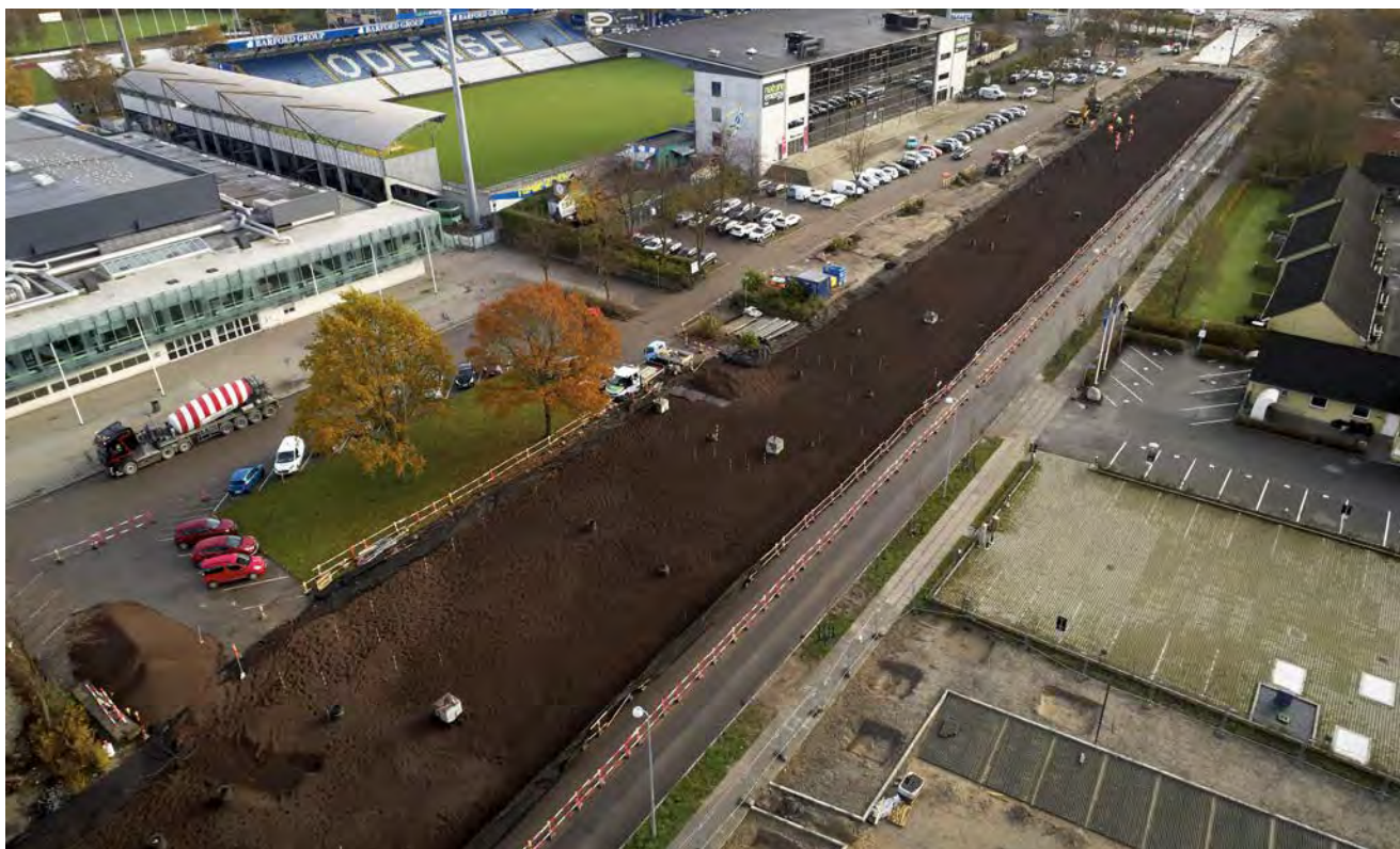
4200 kubikkmeter Leca lettklinker ble brukt på den 300 meter lange strekningen.
