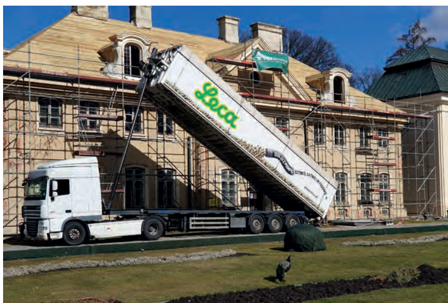
En lastebil med trykkluffsaggregat blåser lettklinker på plass.
