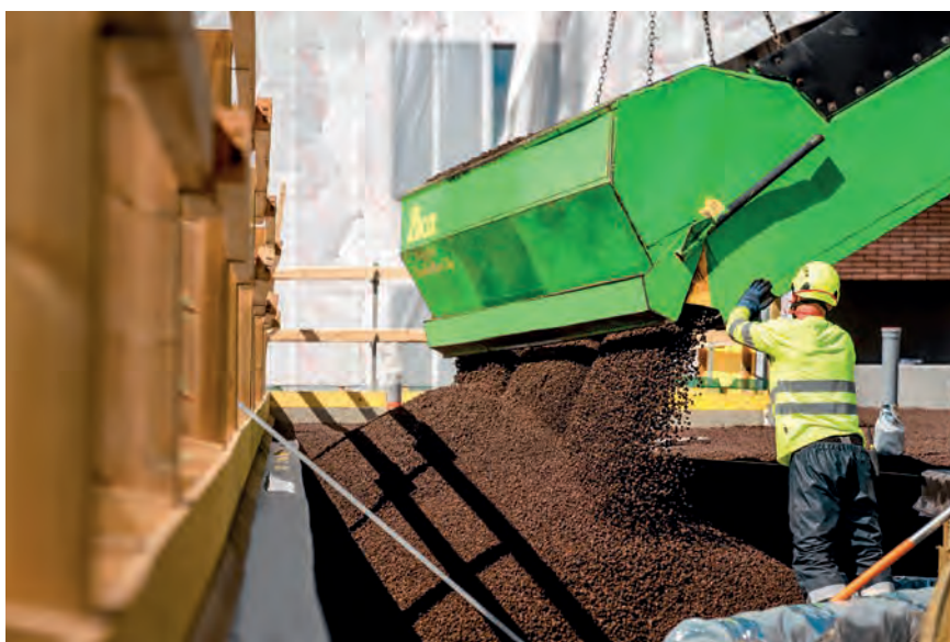
Leca lettklinker ble levert raskt og enkelt med løftekasse.
