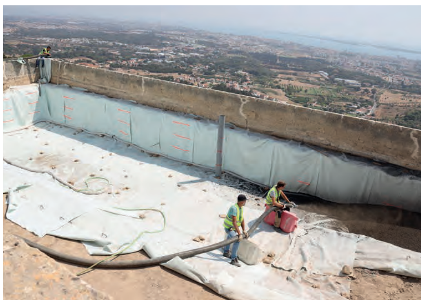
Leca lettklinker ble blåst direkte på plass med trykkluft.
