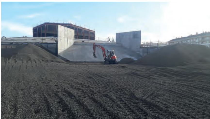
Komprimering av Arlita lettklinker.
