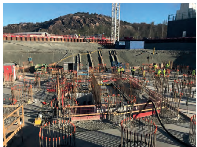
En lastebil med blåseaggregat leverer Leca lettklinker direkte i tårnfundamentet.
