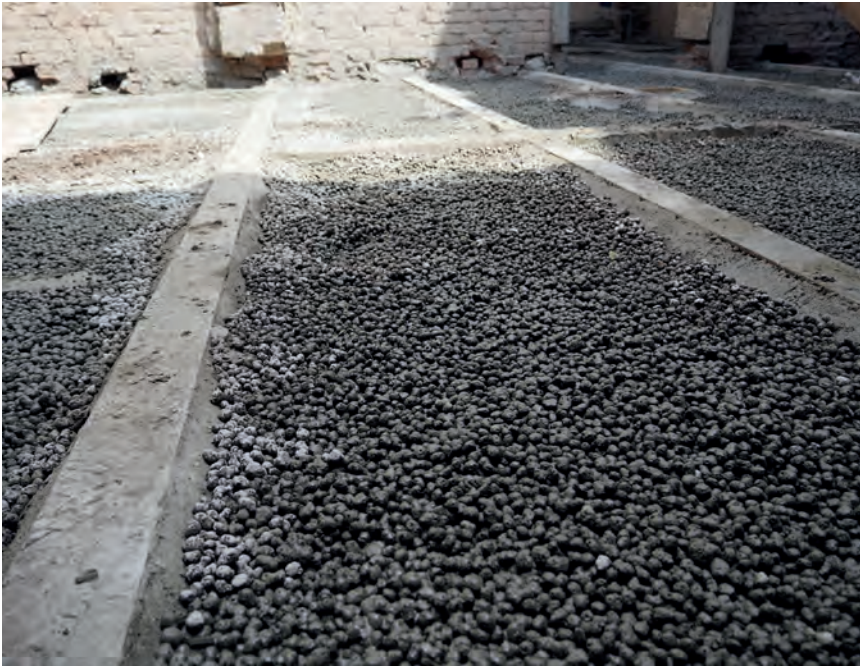
Leca lettklinker mellom bjelkene i taket.
