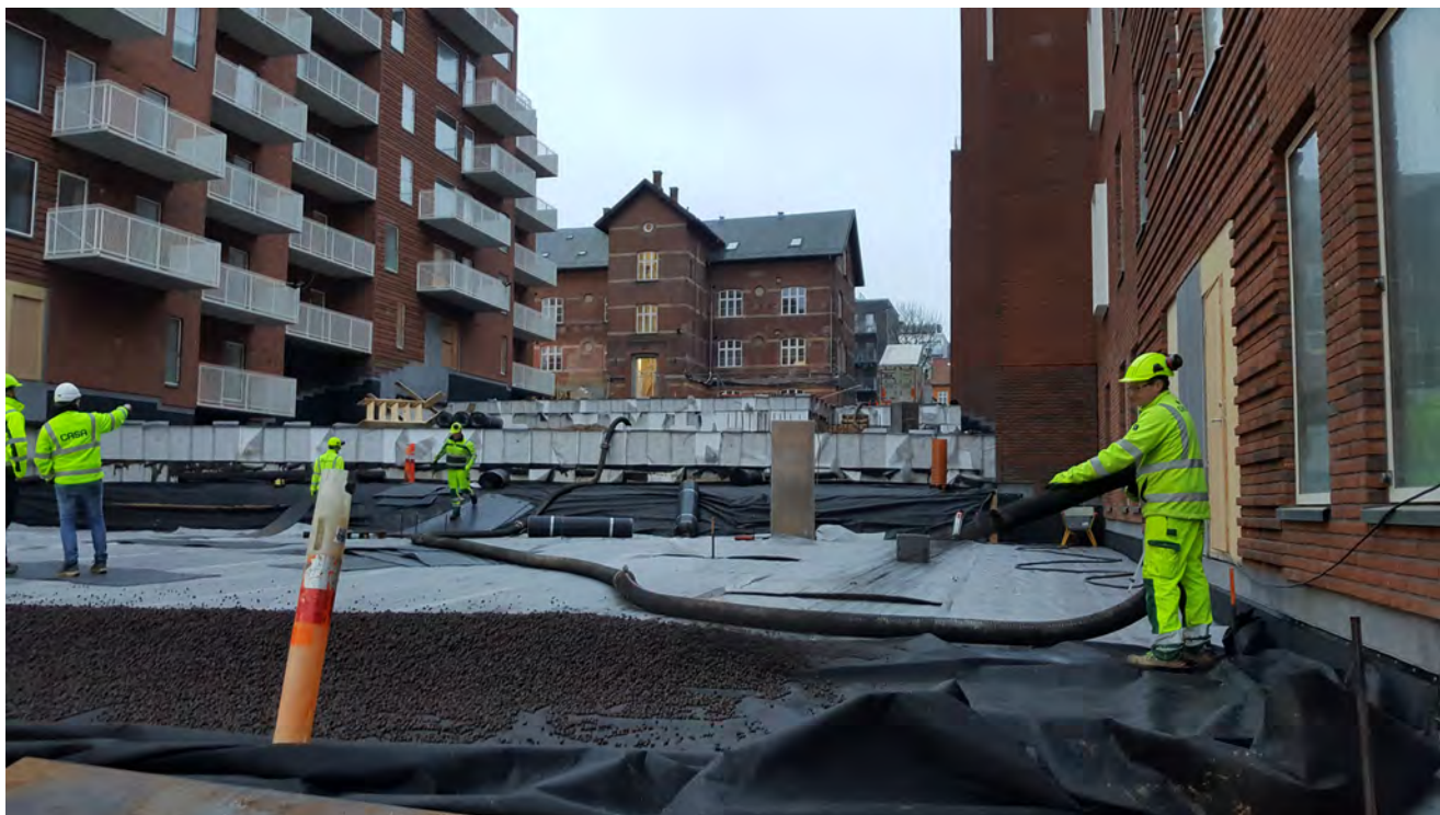
Gårdsplassen ble bygget i flere seksjoner på grunn av det skrånende terrenget.
