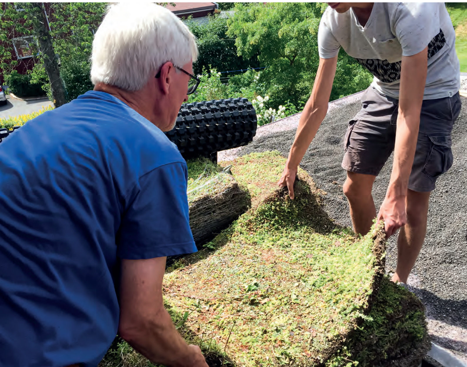
Knust Leca 0–6 mm ble brukt for å maksimere vannfordrøyningen da Bent C. Braskerud bygde et grønt tak på huset sitt i Oslo.
