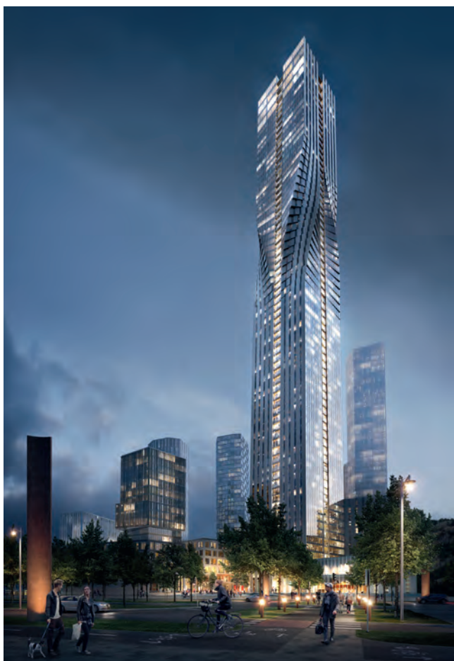
Karlatornet blir 245 meter høyt og får 73 etasjer.
