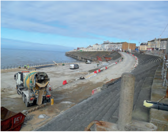
4000 kvadratmeter Leca lettklinker gikk med til å fylle tomrommet mellom den eksisterende sjømuren og den nye muren.
