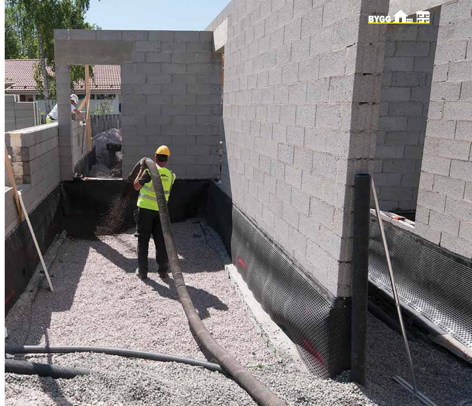
Rundt 700 mm Leca Lettklinker ble blåst inn på fundamentet hver garasje.
