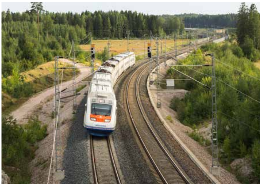
Planlegging av jernbaner krever spesiell geoteknisk kunnskap.
