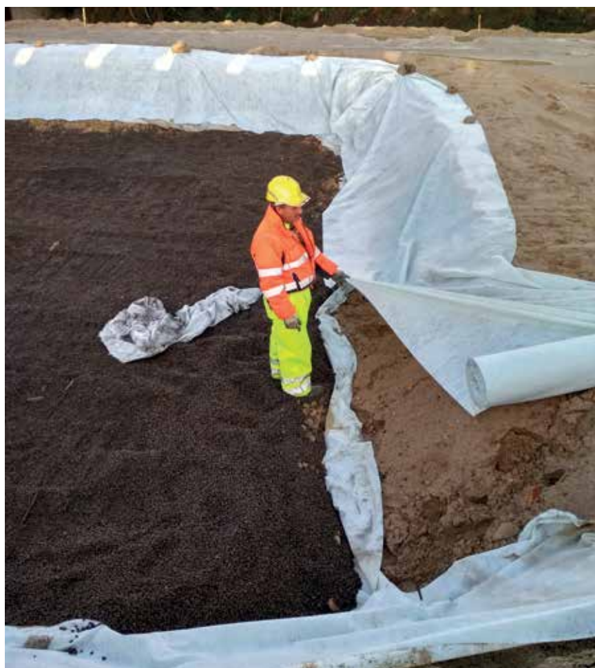
Utlekking av geotekstil i polypropylen (250 gr/m²).
