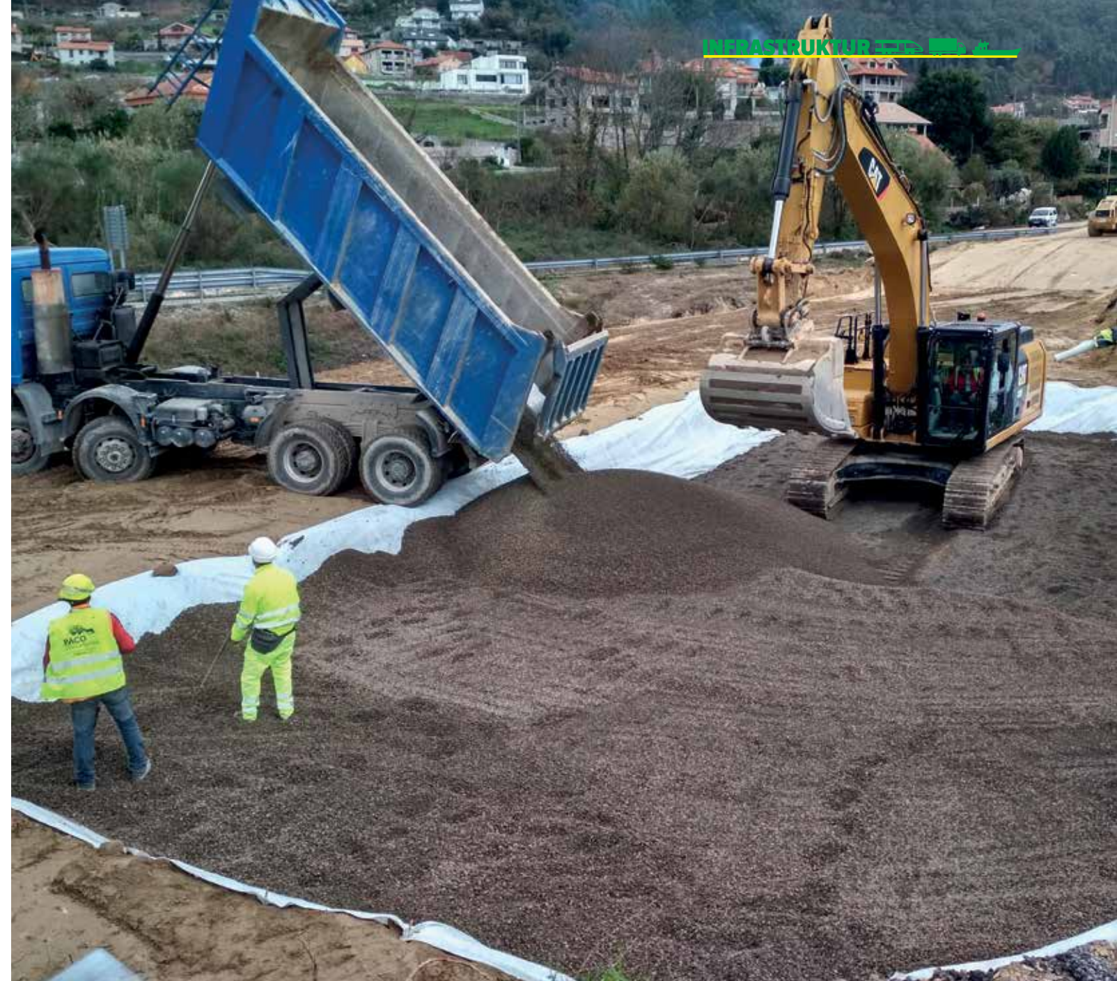
Utlekking av Arlita® i bærelaget.
