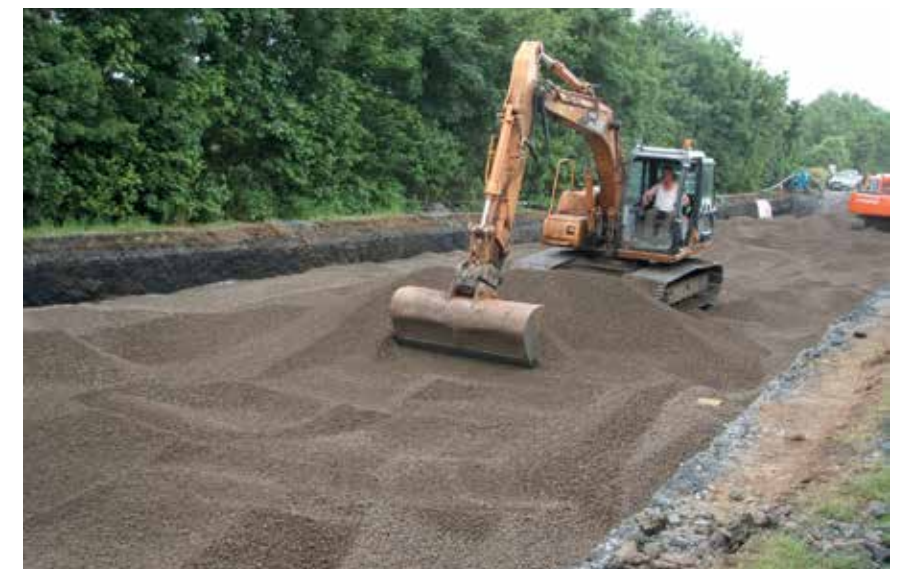
Styrken og komprimeringsmulighetene til Leca Lettklinker gjorde det mulig å la tunge maskiner utføre jobben.
