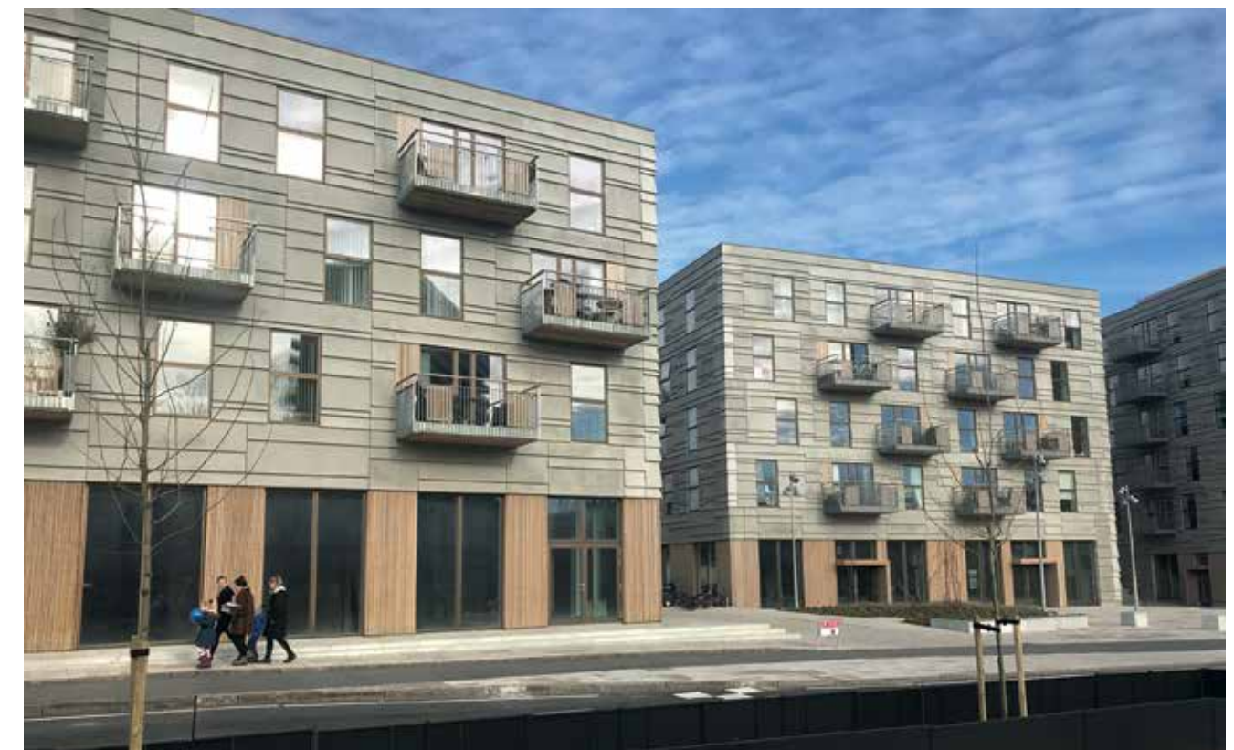
Leca® Lettklinker ble brukt til drenering i kjelleren, og på toppen av en underjordisk parkeringsgarasje
