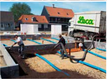
Leca Lettklinker ble levert via den smarte blåsebilen, for enkel installasjon.
