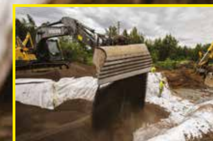
Totalt 2500m 3 Leca ble brukt på anlegget.
