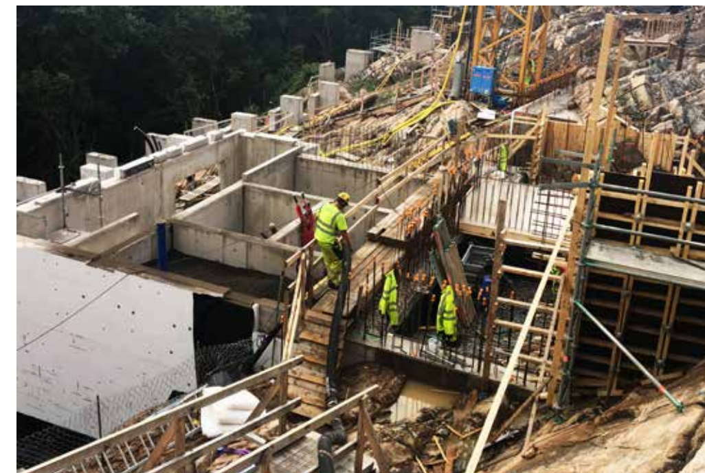
Leca Lettklinker ble levert på byggeplassen.
