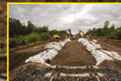
På grunn av levetid og vekt er Leca et utmerket materiale for slike jobber.
