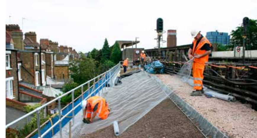
Stabilisering av underbygningen langs en 200 m strekning mellom Acton Town og Chiswick Park.
