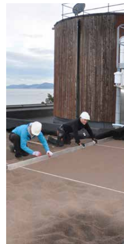
Leca-materialet ble nivellert med rettholt og ikke mekanisk komprimert.
