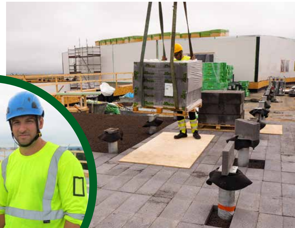
Jouko Partanen (venstre), Leca Finlands erfarne bygnings-ekspert og S-Kattos Pavel Nikolajev på byggeplassen på taket til sykehuset i Hyvinkää.
