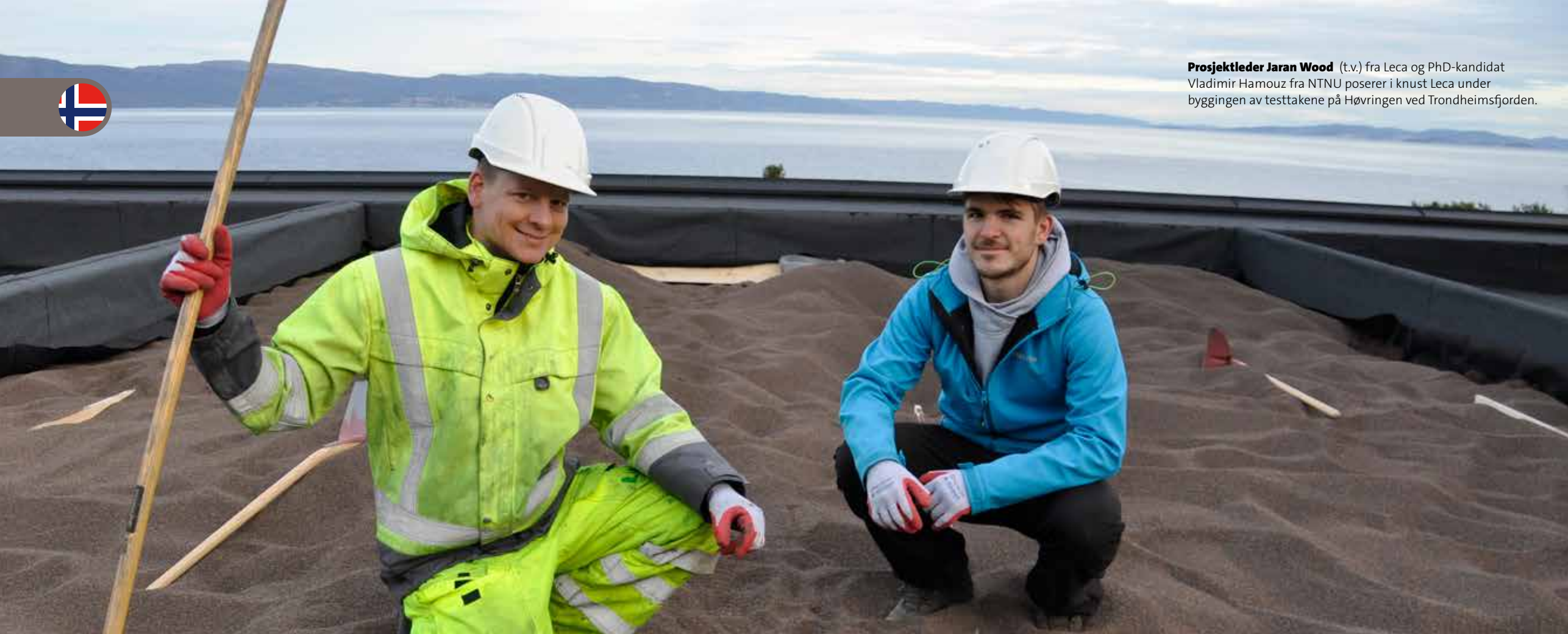
Leca-materialet ble nivellert med rettholt og ikke mekanisk komprimert.
