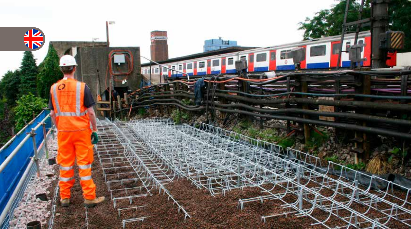
Leca lettklinker ble installert i Ramwall-systemet som lett fyllmasse.
