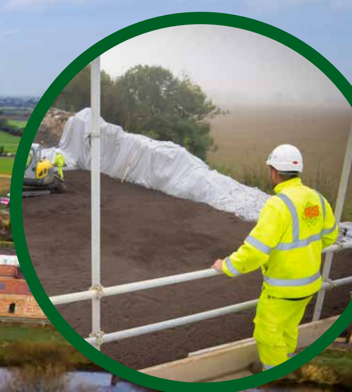
Leca lettklinker ble ansett å være det ideelle materialet, da det kun veier en fjerdedel av vanlig jord.
