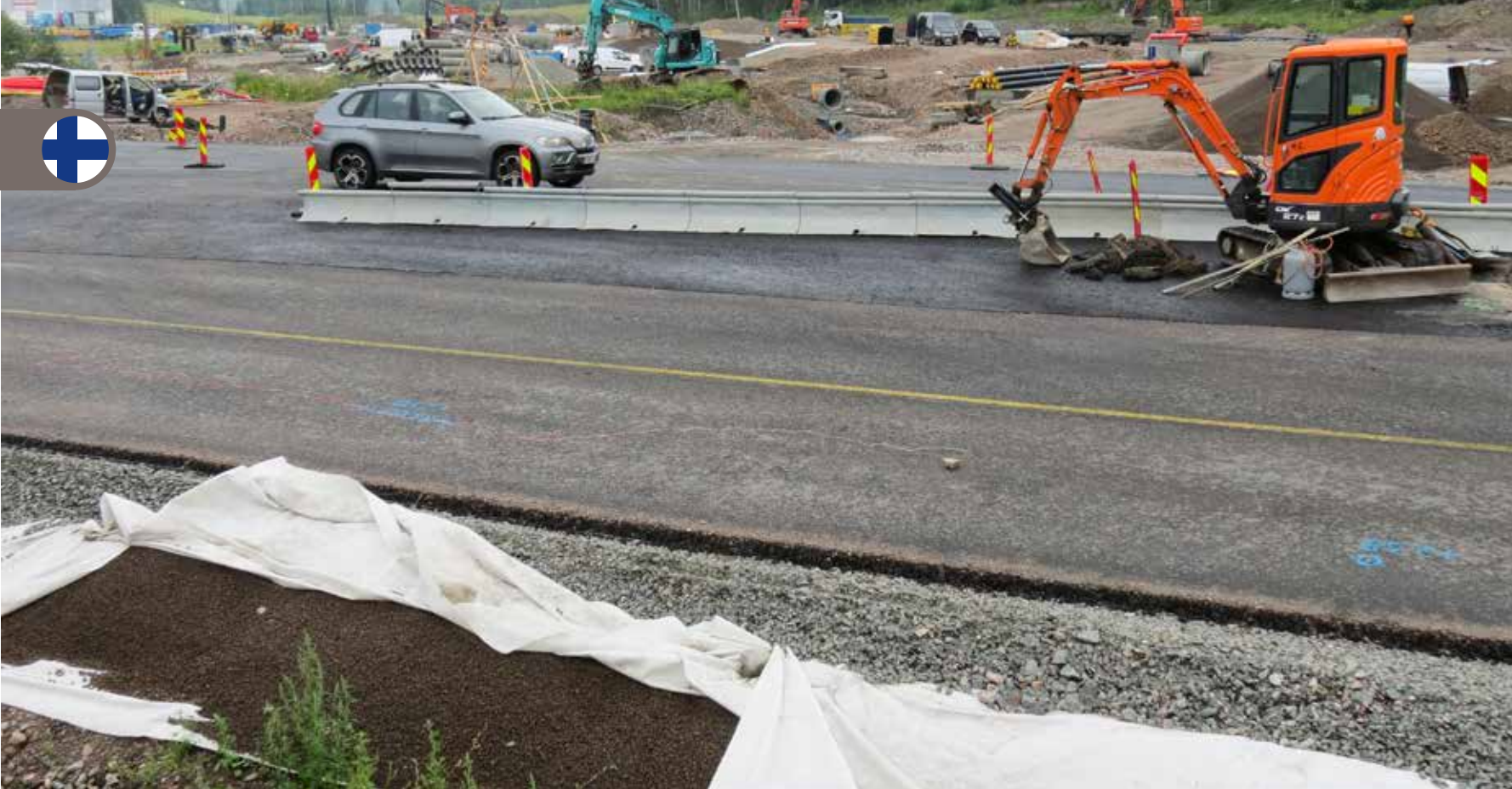
Ferdig lagt vei med Leca lettklinker som grunnlag.
