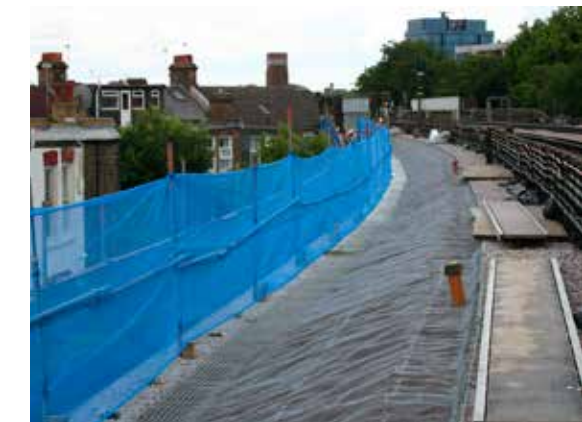
Stabilisering av underbygningen langs en 200 m strekning mellom Acton Town og Chiswick Park.
