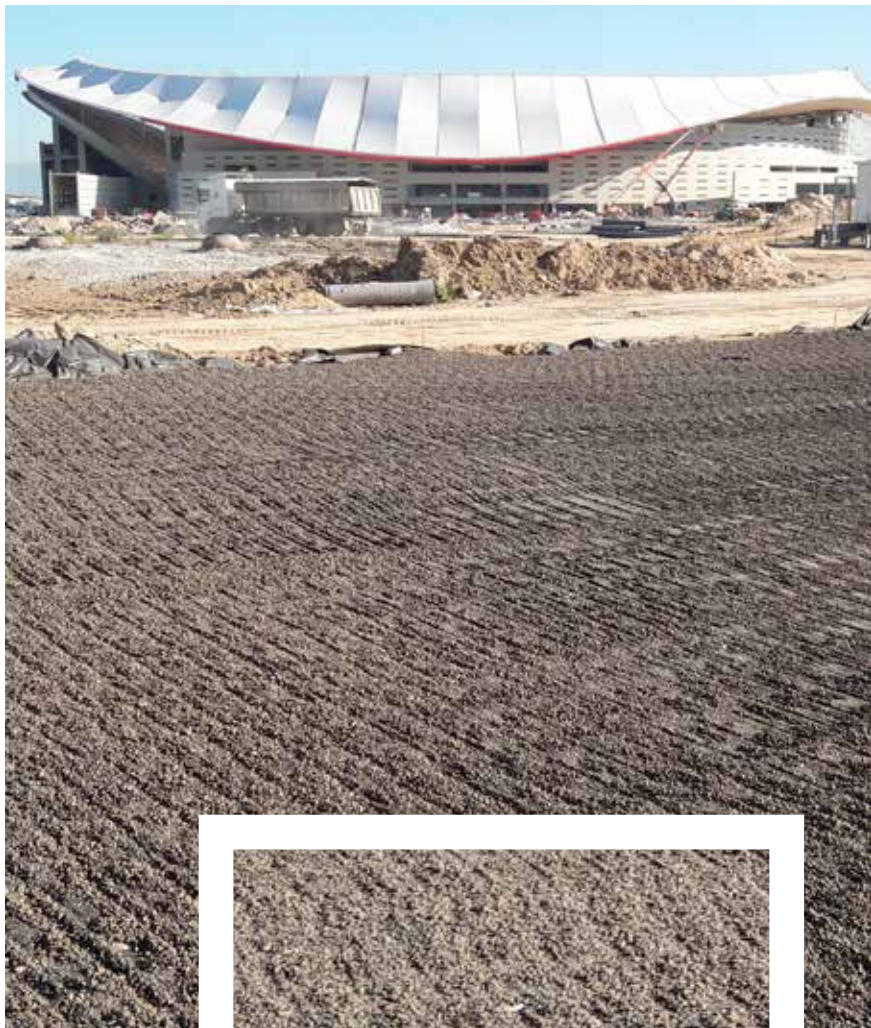
Arlita etter komprimering.
