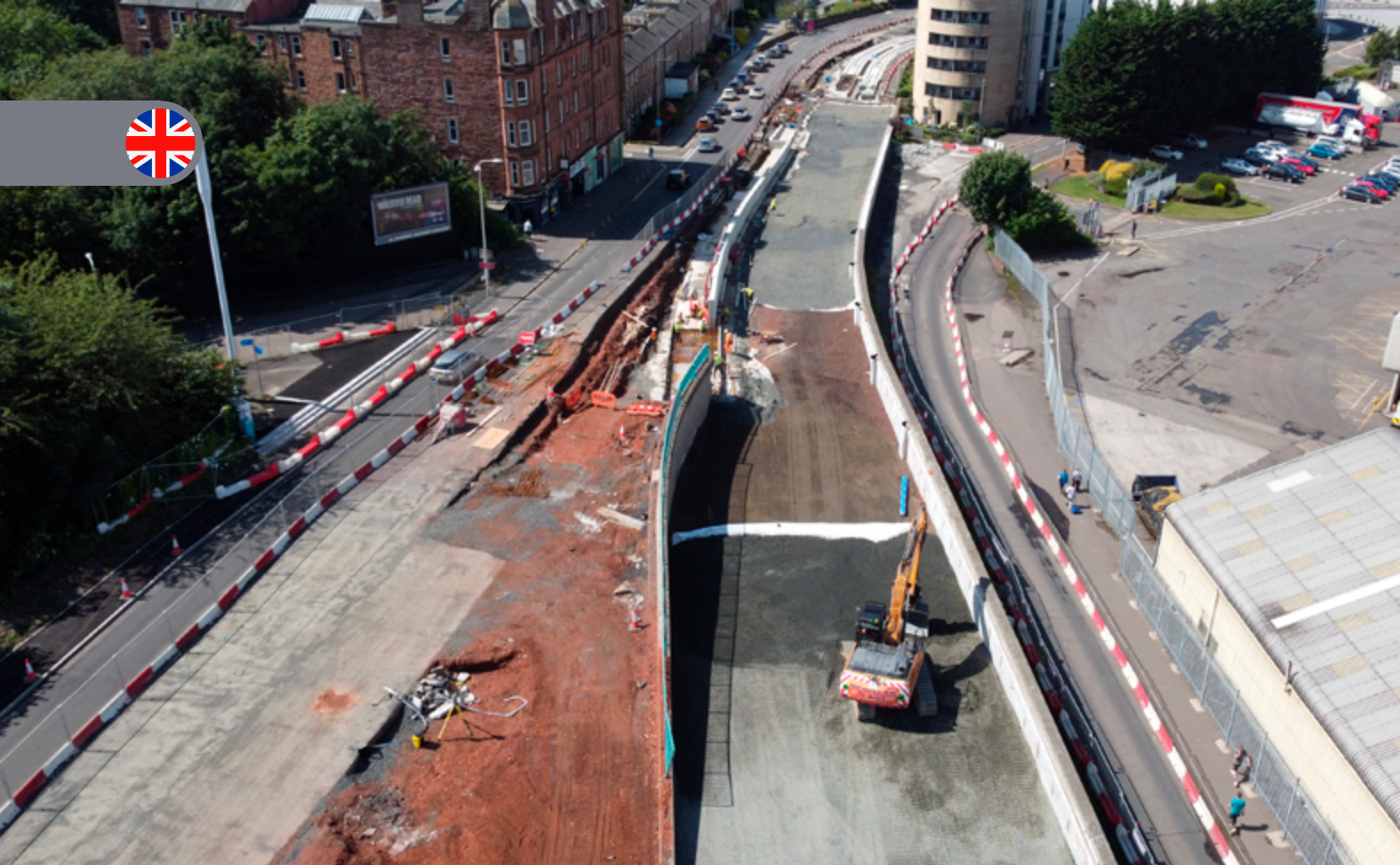
Kompremeringen av Leca® Lettlinker og redusering av press på konstruksjonen.
