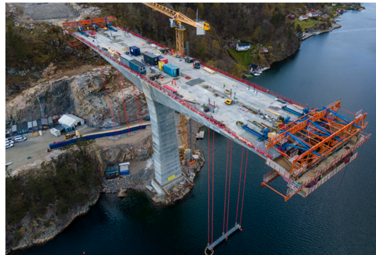
Nye Veier's E39 prosjekt mellom Kristiansand og Stavanger er Norges største veiprosjekt.
