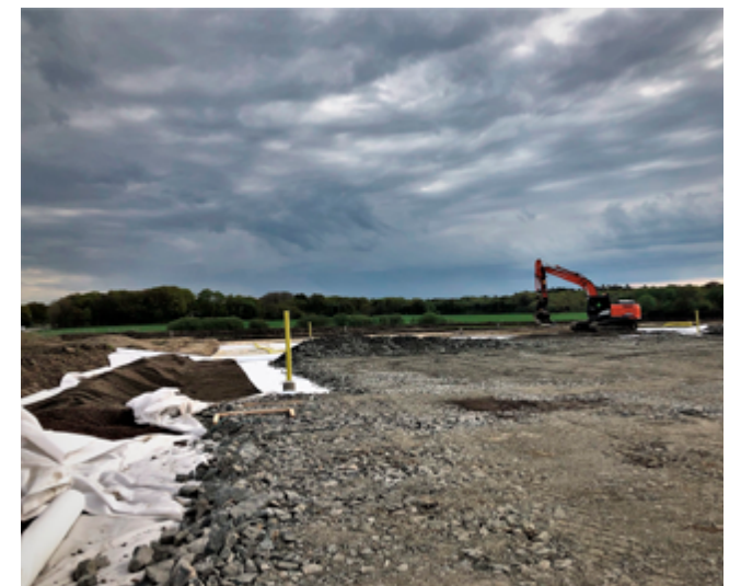
Et solid fundament som vil redusere risikoen for setningsskader.
