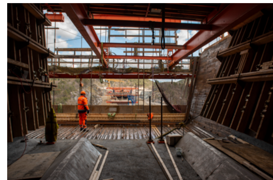
STØPEVOGN: Forskalingsvognene brukes til å støpe fem meter brospenn av gangen, på hver av de fire endene samtidig.
