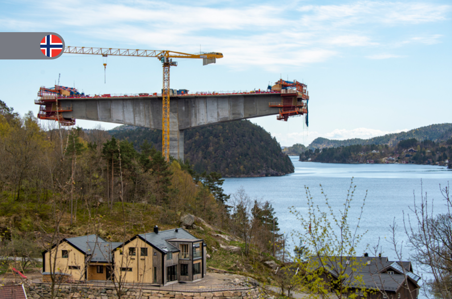
Balansekunst: Støpingen av 260 meter lange spenn rett ut i luften, 64 meter over Trysfjorden, er helt opp mot grensen av det mulige.
