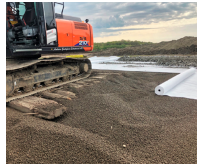
Et lag med geotekstil legges først ut og Leca Lettklinker oppå.
