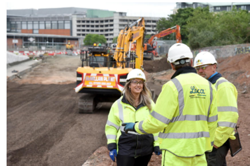
Leca Lettlinker ble spesifisert som en løsning for å gi et robust fundamentstøtte for sporbunnen mellom to eksisterende støttemurer
