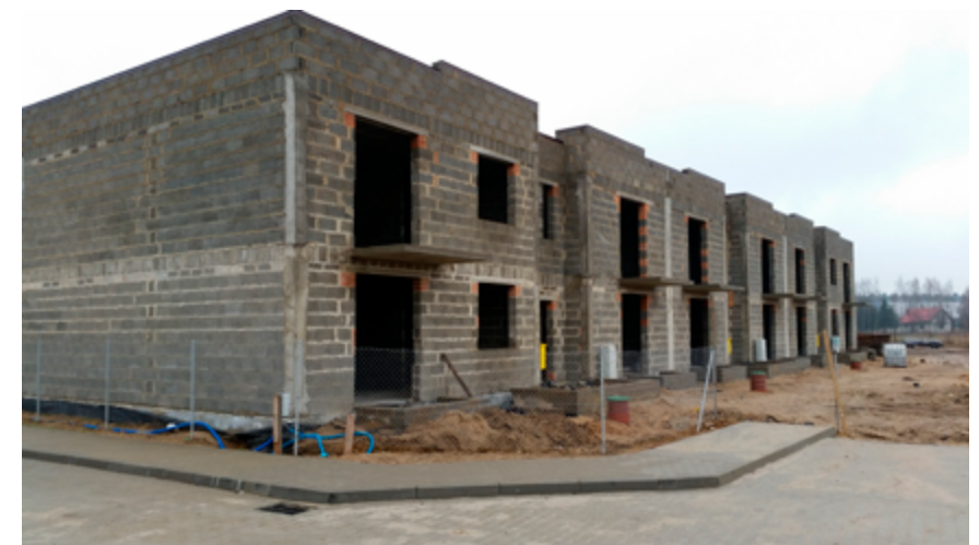
Rekkehuset under bygging.
