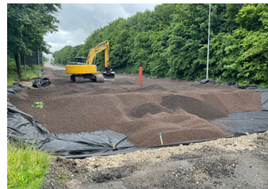
Leca Lettklinker ble lagt i et lag på 1 meter tykkelse og komprimert med en platevibrator.
