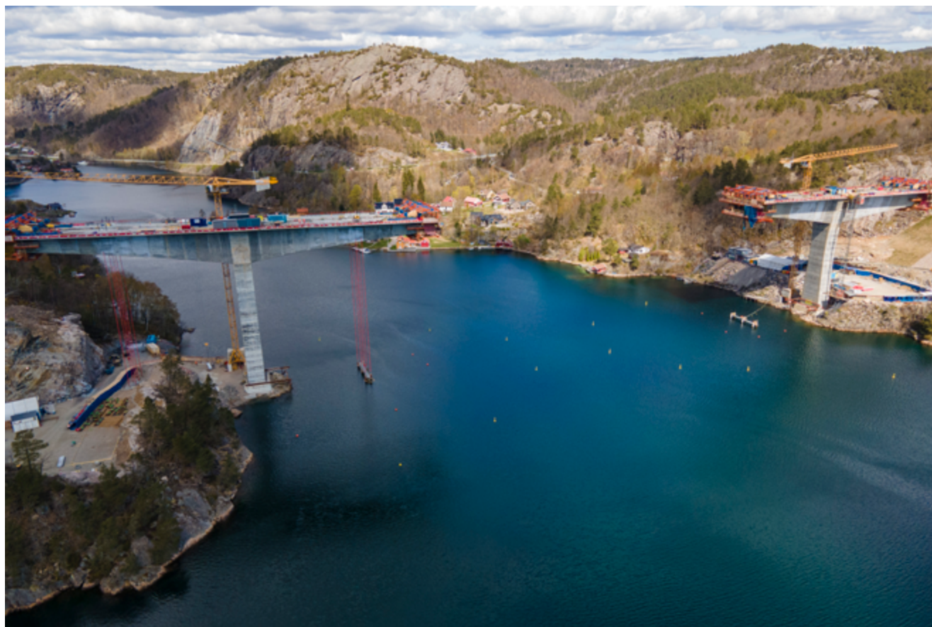
T-ENE VOKSER: Hvert brotårn vokser med 20 meter i måneden. Neste sommer skal broen stå ferdig. Foto: AF Gruppen
