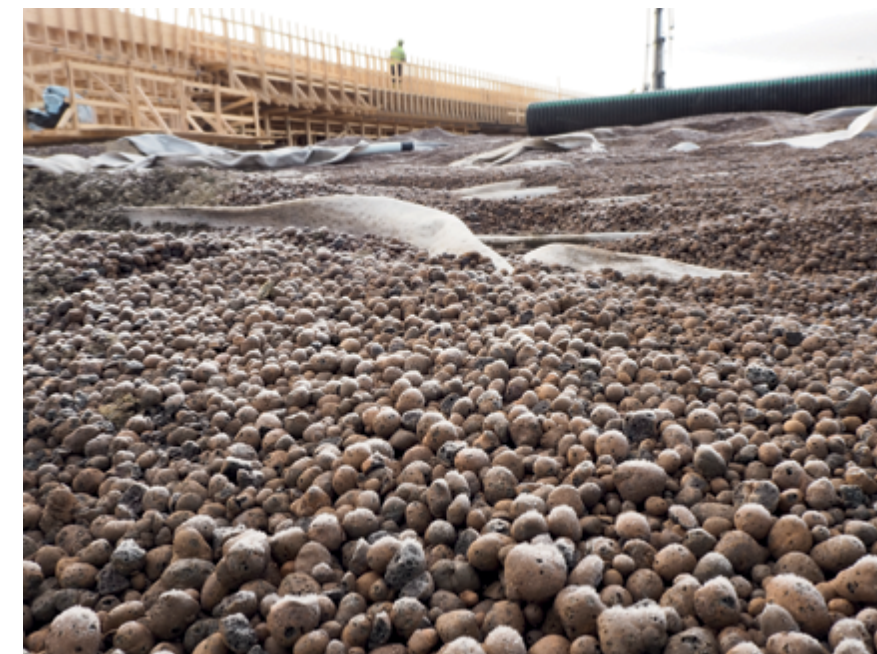
Det brukte materiale var i utmerket tilstand.
