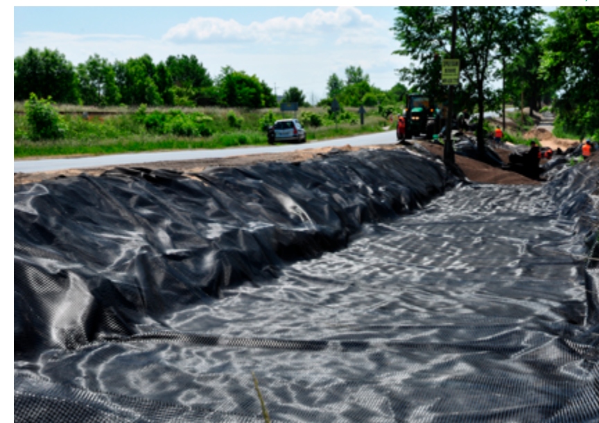
Lag med geotekstil .
