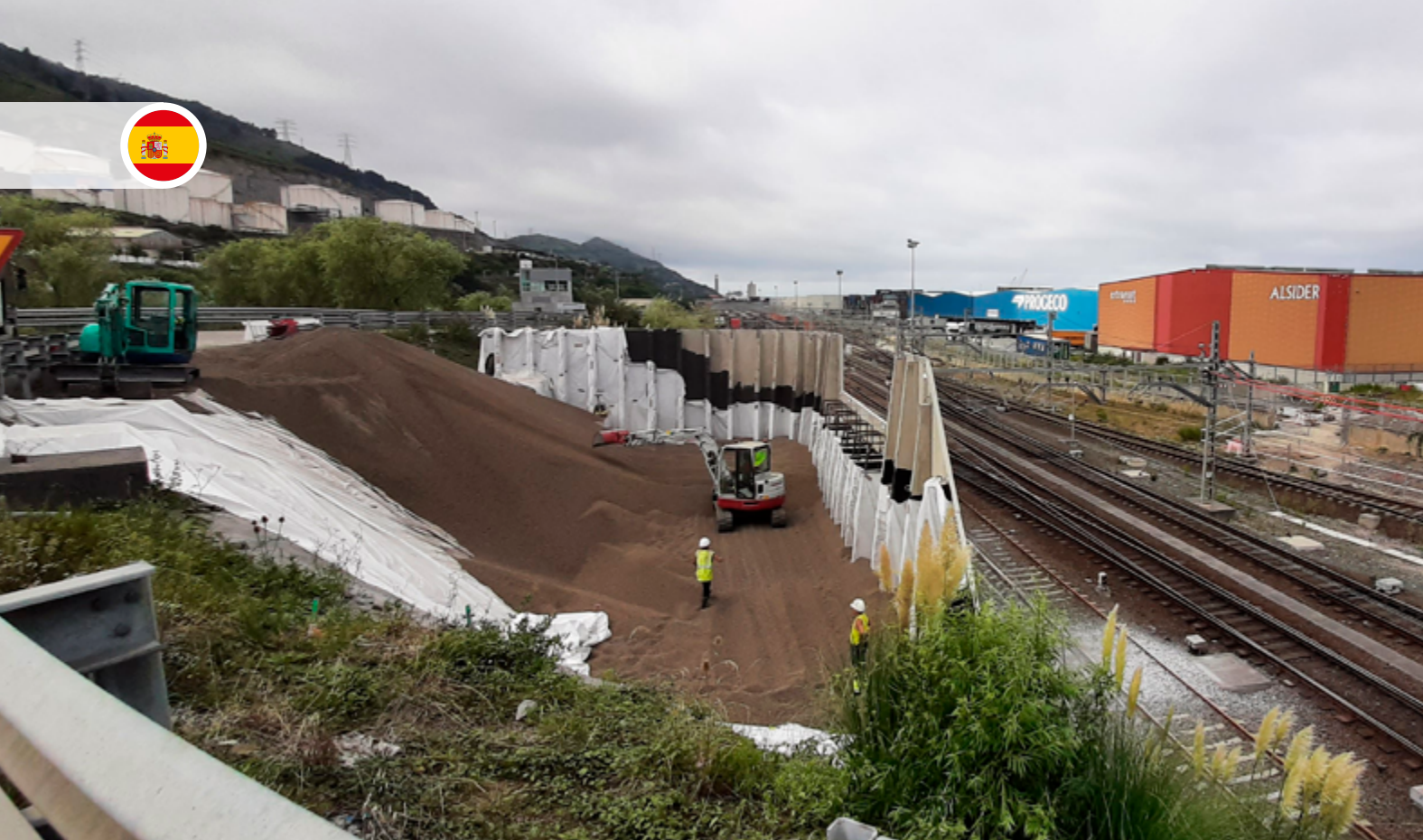
Den nye tilgangen til havnen i Bilbao er i hovedsak en bro som forbinder N-644 med havnen over jernbanesporene.
