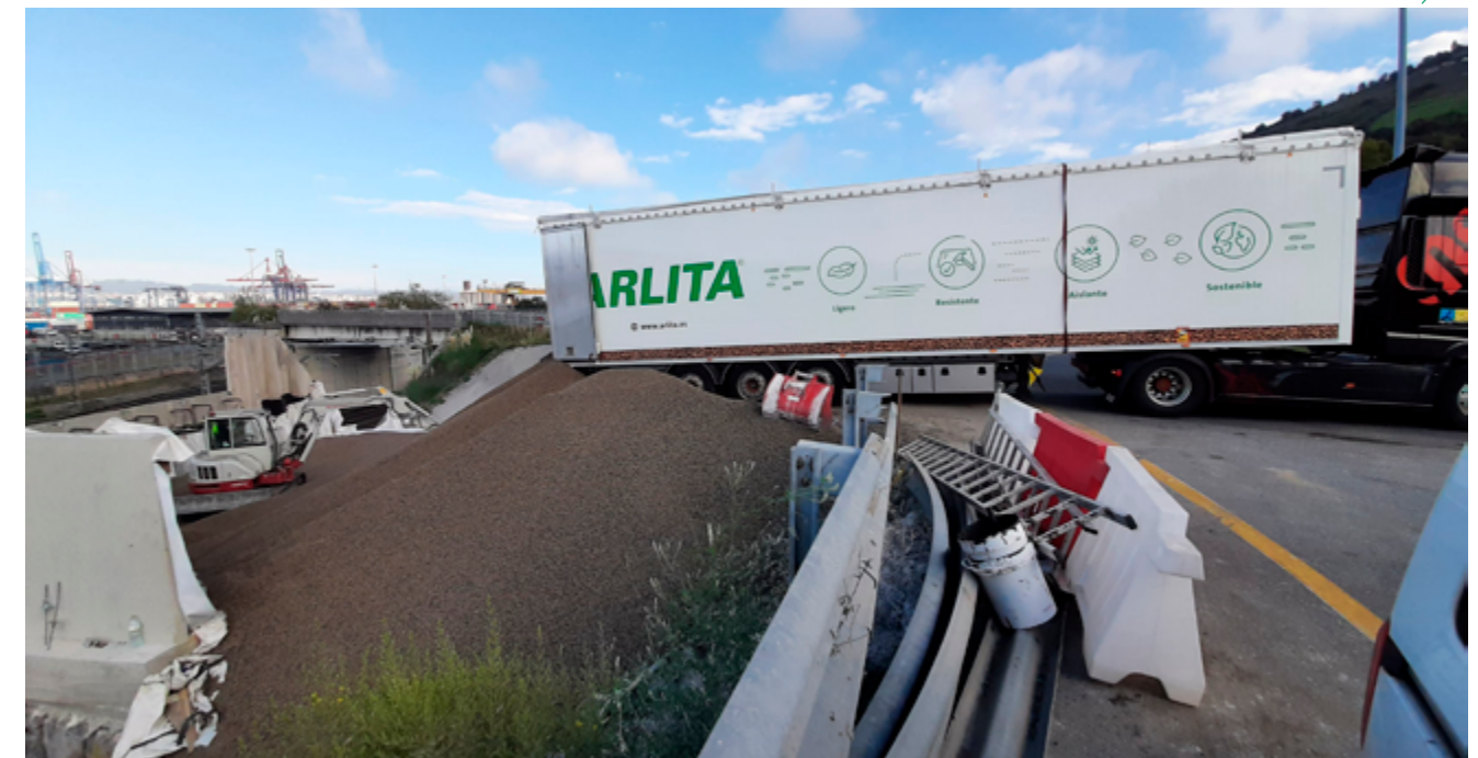
Den reduserte belastningen som Leca® Lettklinker gir mot bakken betyr også at den ikke krever noen behandling utover fjerning av eksisterende planter.
