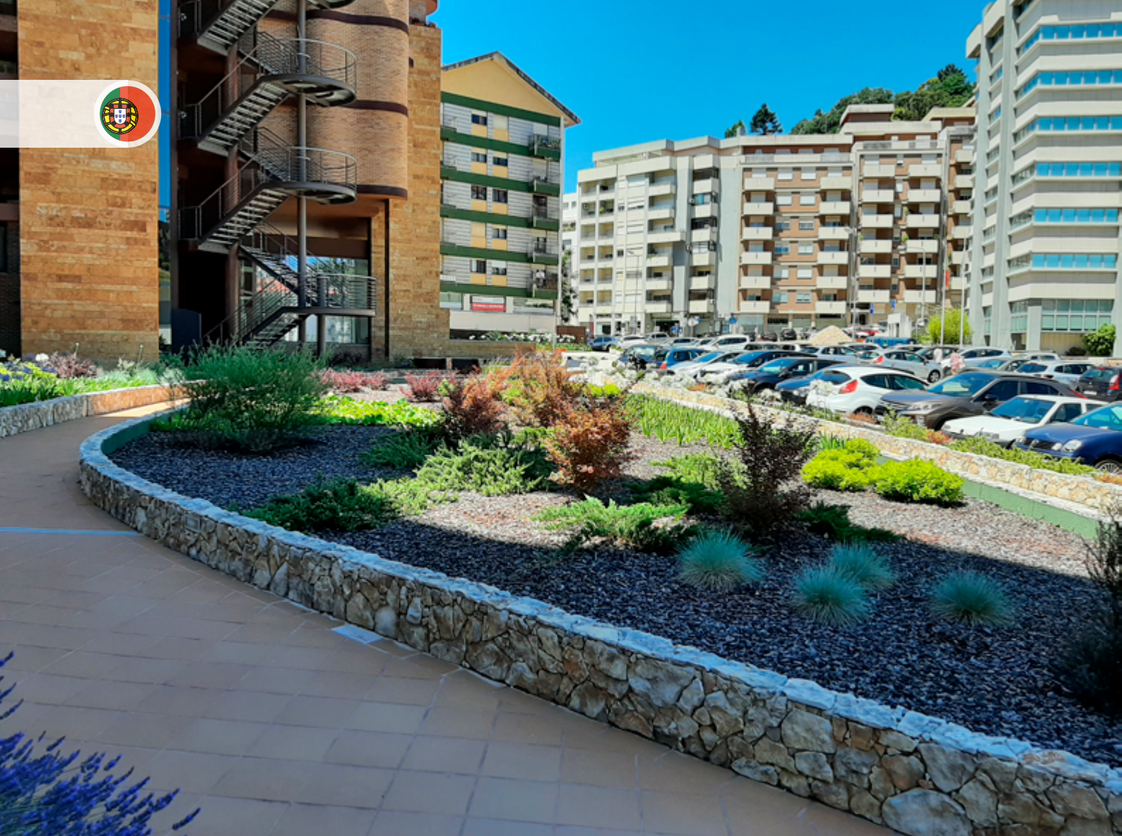
Leca® Lettklinker ble brukt som fyllmateriale for et grønt takprosjekt.
