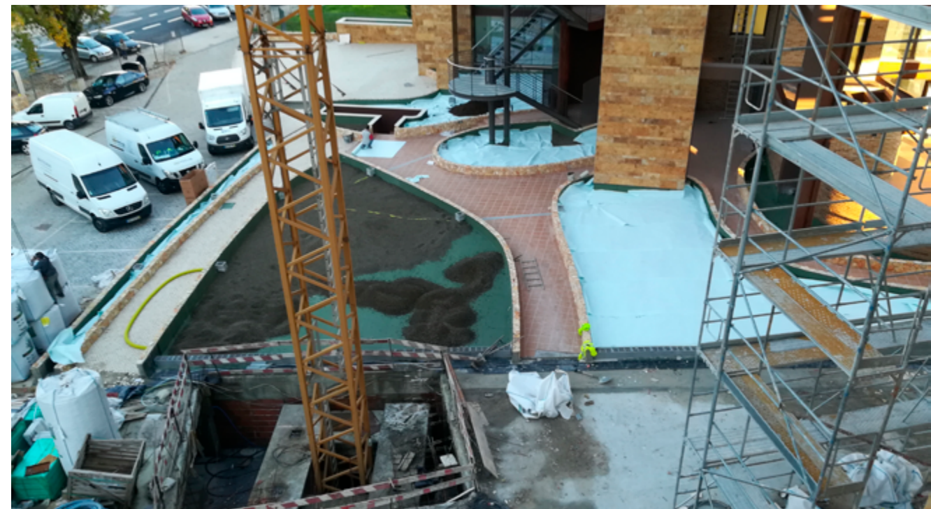
Totalt ble 400 m³ med Leca® Lettklinker brukt i prosjektet, levert i små sekker og bulksekker.
