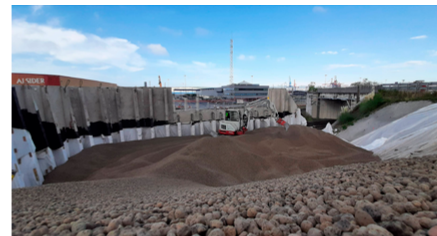
Fyllingen av brofestet ble gjort med Leca® Lettklinker, noe som gir kontroll over setninger for fremtiden.
