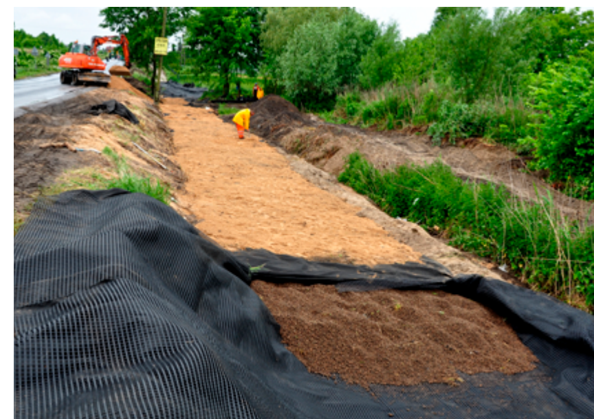
Fylling og underlag for broleggingen blir dekket.
