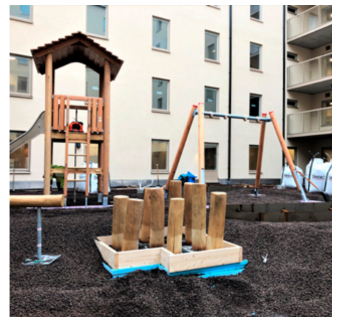
Gjennom bruk av Leca® Lettklinker kunne den vertikale vekten reduseres betydelig.
