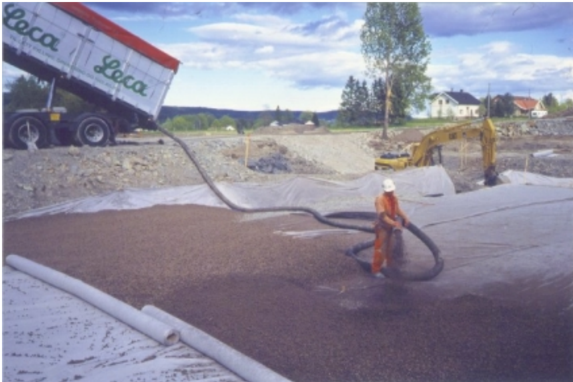
Figur 7.10 Frostsikringslag av Leca Lettklinker under utlegging i jernbanetrau.
