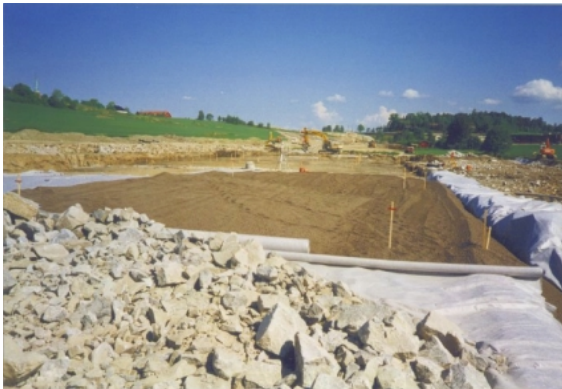
Figur 7.5 Lav vegfylling av Leca på meget bløt grunn ved Vestby (her valgt i stedet for kalk/segment peler).
