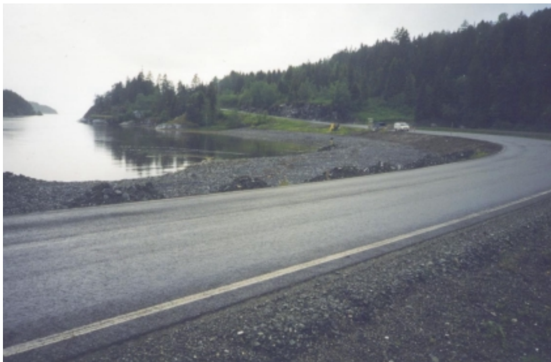
Figur 3.1 Tysknebben i Nord-Trøndelag med vegstrekningen på Leca-fylling.
