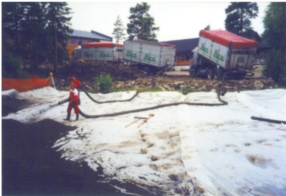
Figur 7.7 Innblåsing av Leca Lettklinker 10-20 mm direkte fra bil.
