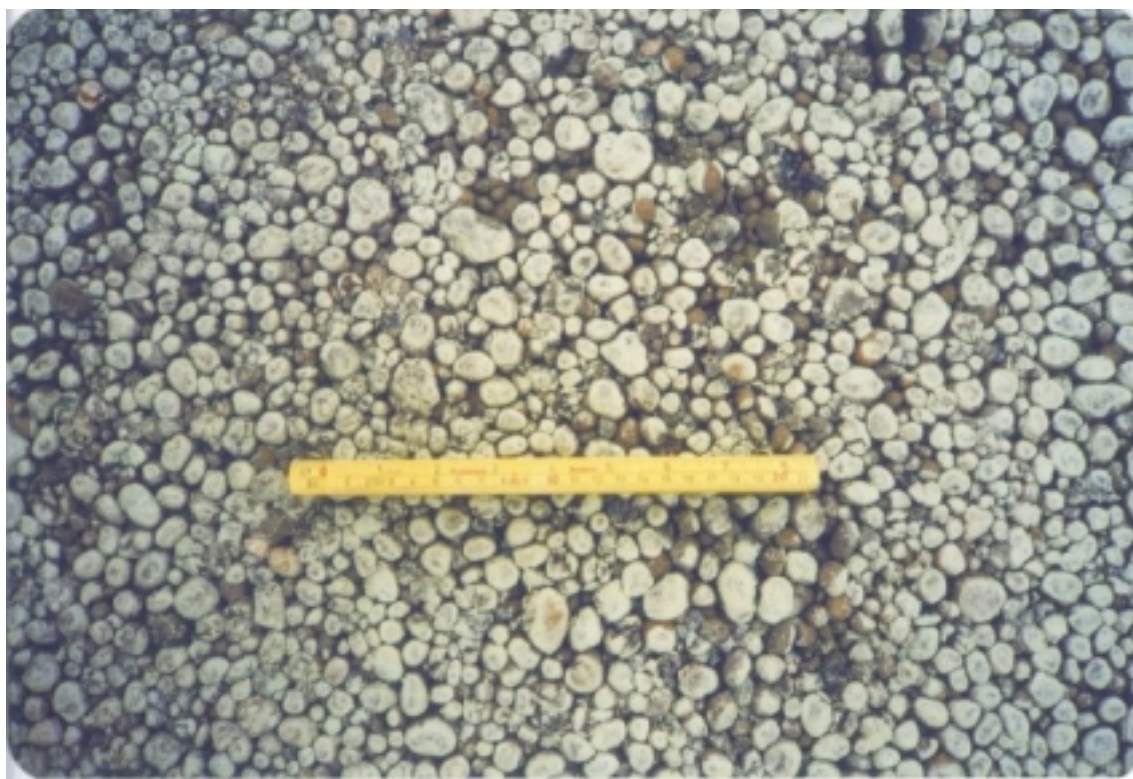
Figur 7.11 Avdekket Leca-fylling under en veg med 40 cm overbygning. Det ble ikke funnet noen indikasjoner på at trafikken skader fyllinga.
