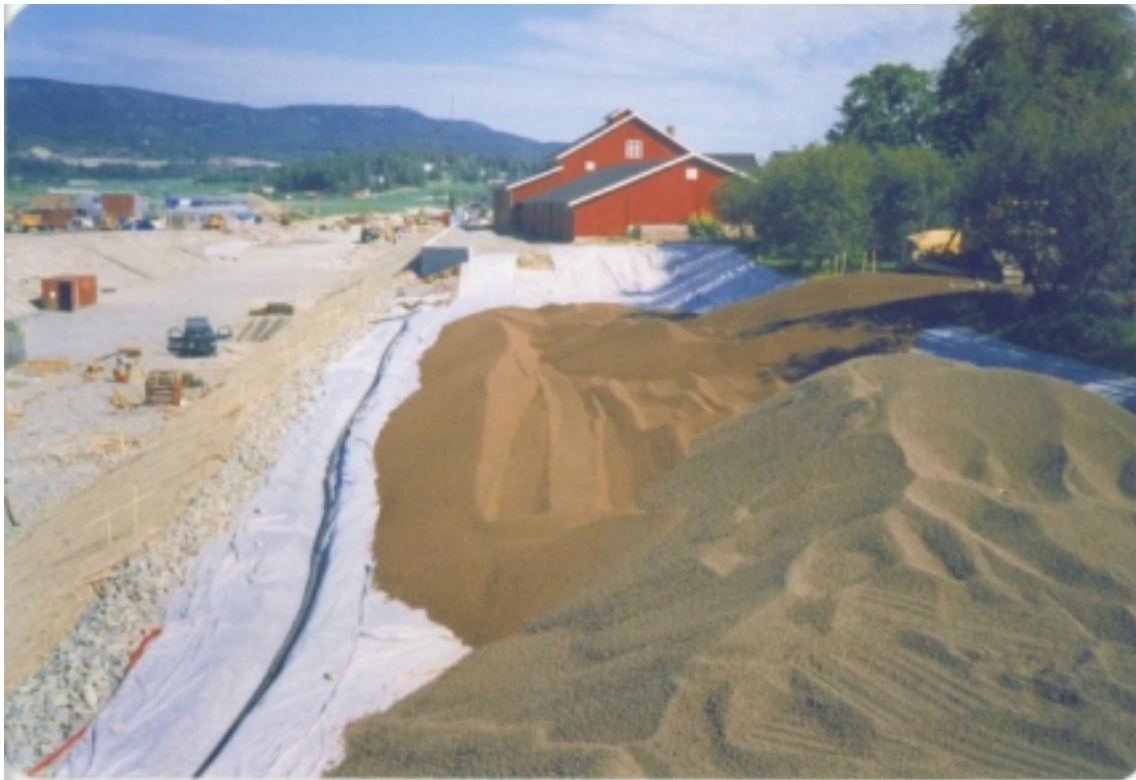
Figur 7.3 Masseutskifting med løs Leca for avlasting av skjæringsskråning ved Sande stasjon.
