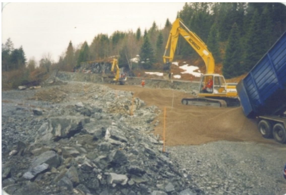
Figur 7.8 Utlegging av Leca Lettklinker med beltegående gravemaskin.
