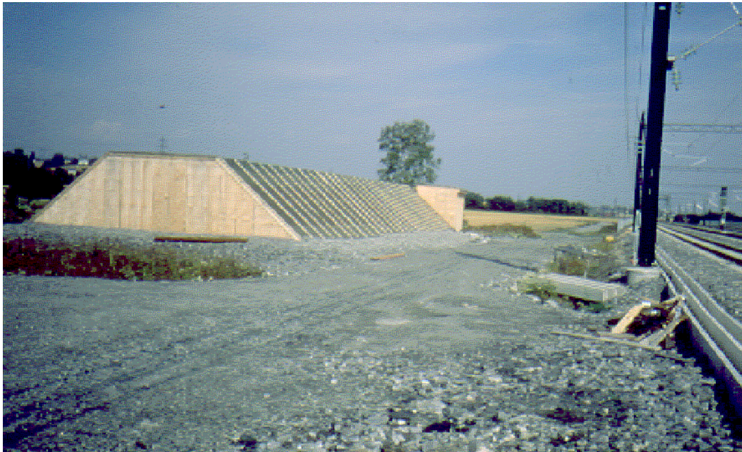
Figur 3.2 Frostforsøksfeltet med nedkjølt bygning ved Gardermobanen på Leirsund
