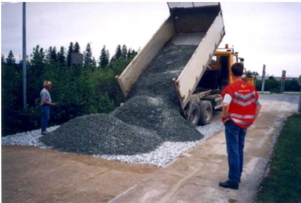
Figur 3.3 Fra bygging av forsøksfelt på Sandmoen
