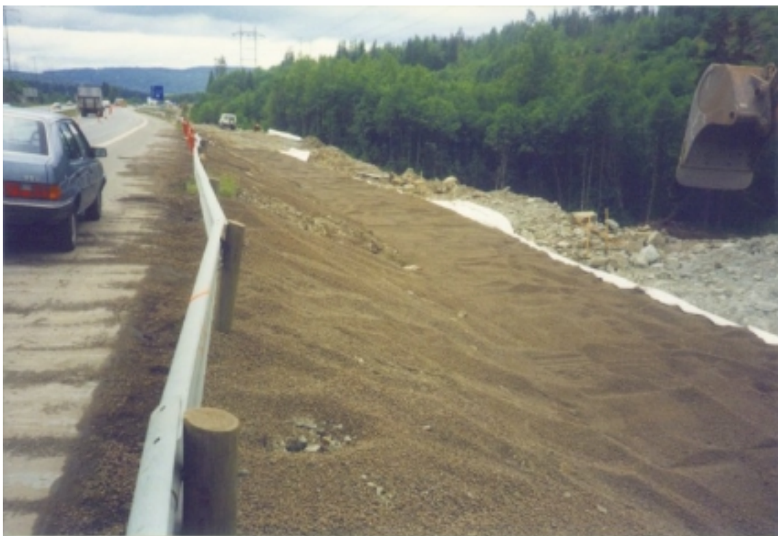
Figur 7.4 Lettklinkerfylling ved breddeutvidelse av E6 nord for Oslo.
