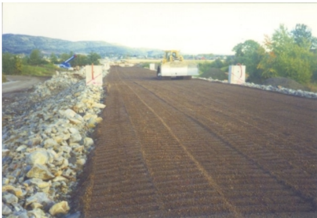
Figur 7.2 Leca-fylling i en ny jernbaneparsell på Vestfoldbanen
