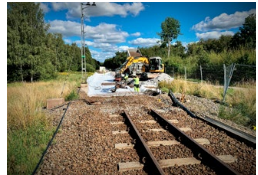
Det ble lagt geotekstil i bunnen.
