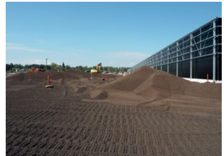
Laget med Leca lettklinker under Seinäjoki Ideapark er mellom 300 og 1200 mm tykt.
