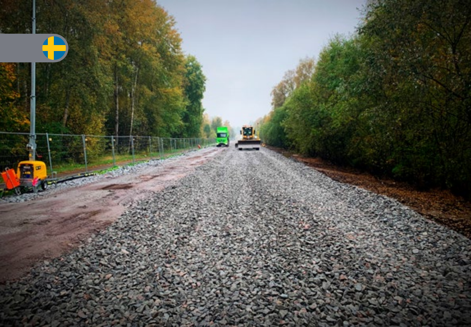
Oppå den ferdige Leca-løsningen ble det fylt pukk før de nye jernbanesporene ble lagt.
