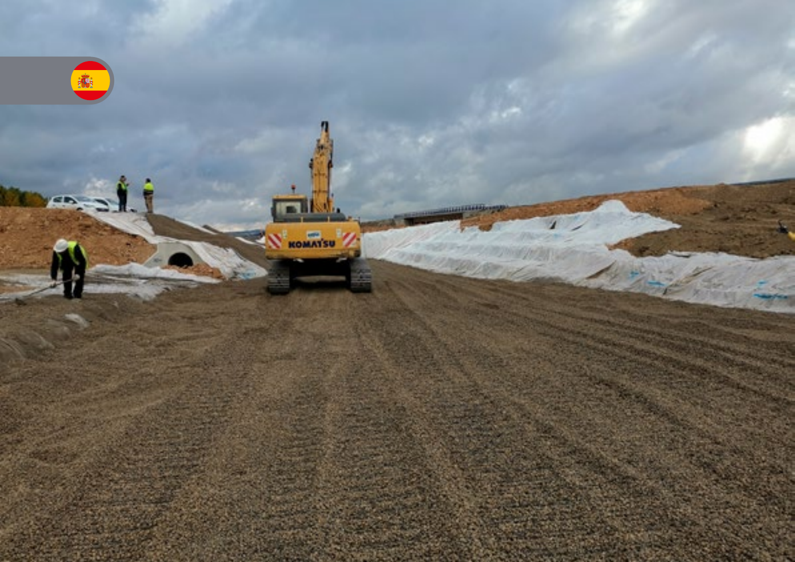
Lettklinker blir spredt utover og komprimert.
