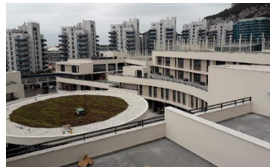
Det ble brukt til sammen 430 000 ulike Isoargila-blokker i de to bygningene.
