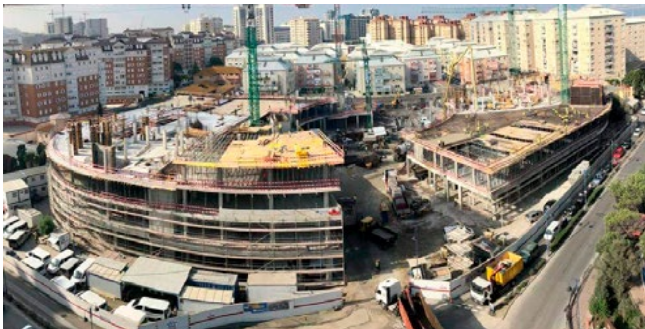
Arkitekten og entreprenøren var på jakt etter løsninger som ville gi et bygg med høy teknisk ytelse.
